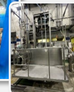
食肉機械設備例 (昇降作業台)
