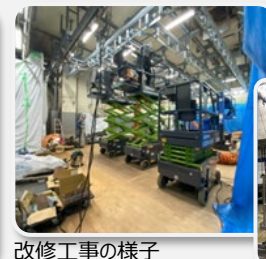
改修工事の様子
