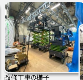
改修工事の様子
