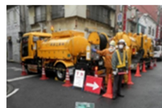
下水道管清掃状況
