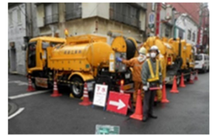
下水道管清掃状況
