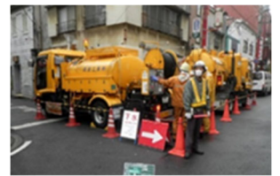
下水道管清掃状況
