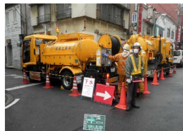
下水道管清掃状況
