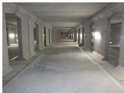
雨水調整池の内部
