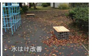
雨水貯留浸透機能をもったベンチの整備（左：施工前、右：施工後）
