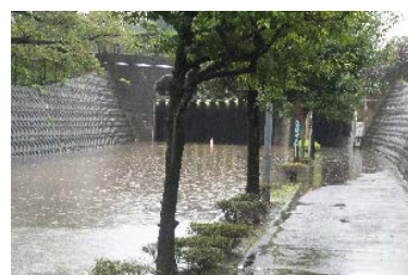
道路冠水状況（保土ヶ谷区）
