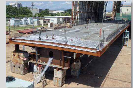
工事状況（橋桁製作）
