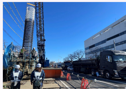
橋りょう基礎杭の施工状況
