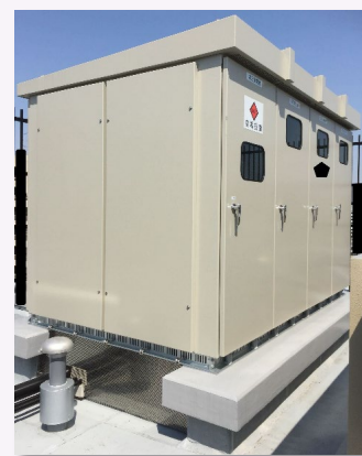
高圧一括受電の受変電設備
