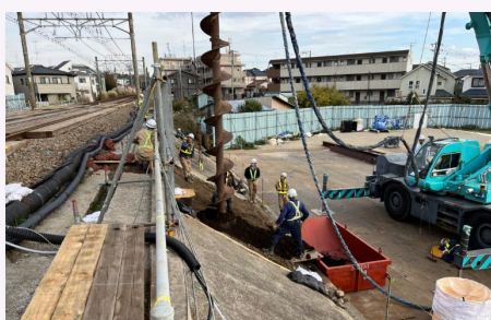
土留杭の施工状況
