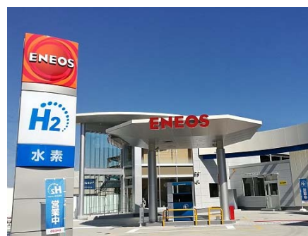
横浜綱島水素ステーション
