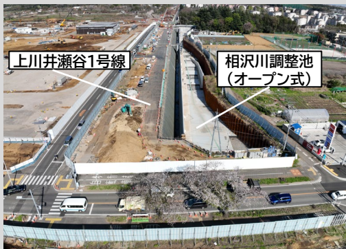
上川井瀬谷1号線等の工事状況
