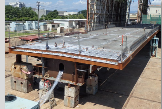
工事状況 (橋桁製作)
