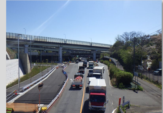
工事状況 (上川井IC付近)
