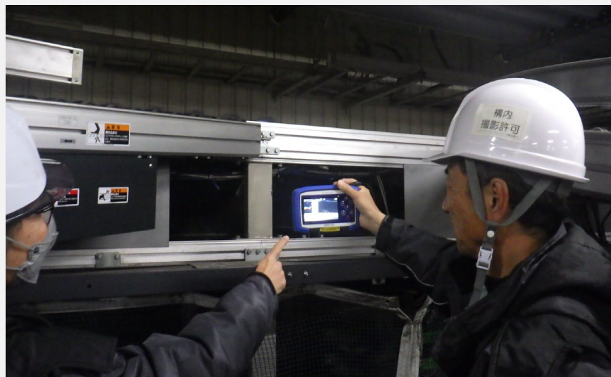
現場確認の様子
