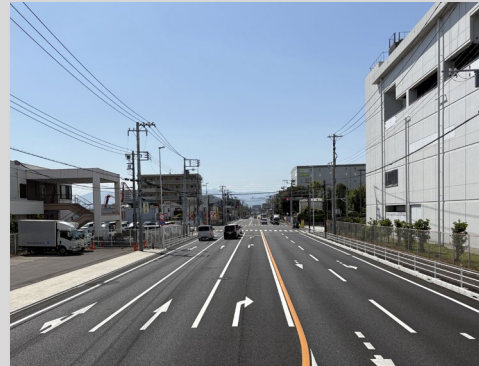
工事状況 (目黒交番前交差点付近)
