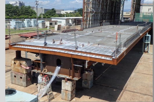
工事状況（橋桁製作）
