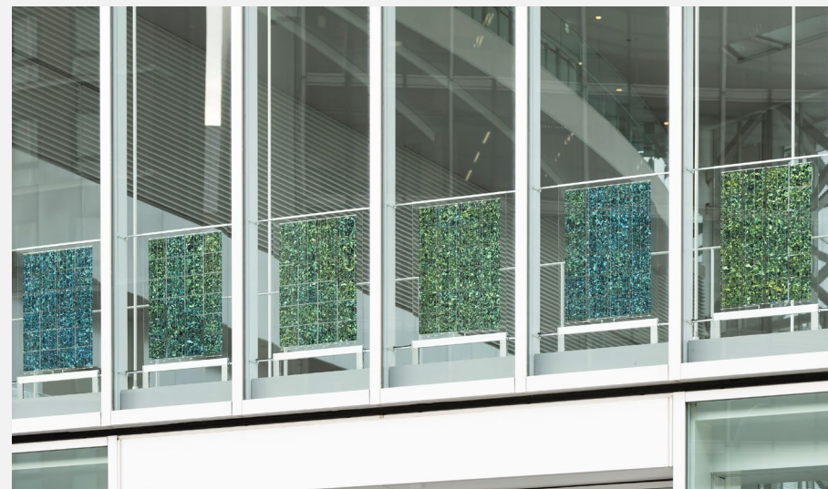
建材一体型太陽電池の設置例(7年度市庁舎アトリウムでの実証実験)
