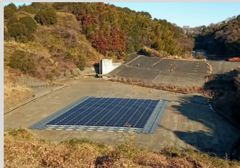
湘南桂台第二雨水調整池（栄区）
