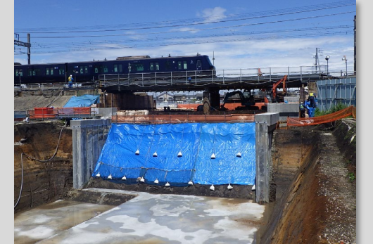
工事状況（擁壁建造）
