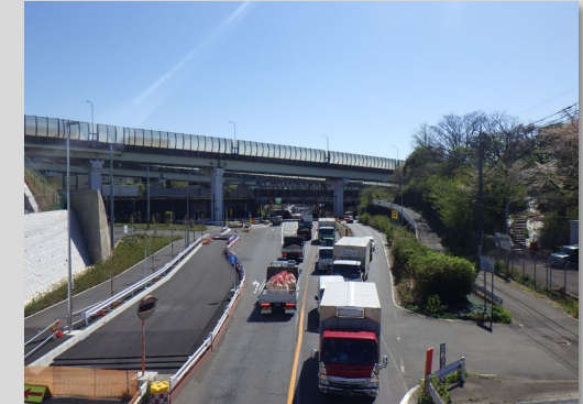
工事状況（上川井IC付近）
