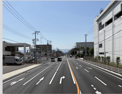
工事状況（目黒交番前交差点付近）
