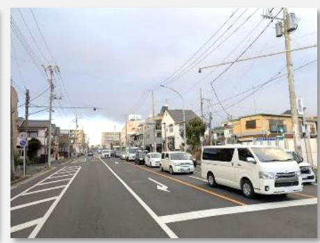
交差点改良(右折レーン延伸)
