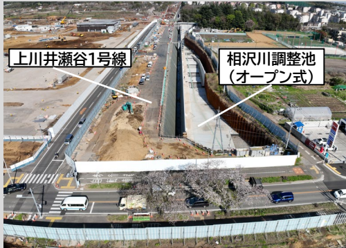
上川井瀬谷1号線等の工事状況
