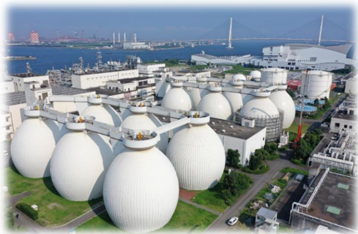
汚泥集約処理の象徴である卵形消化タンク
