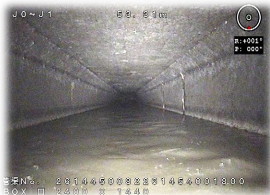
下水道管内の状況(腐食の一例)
