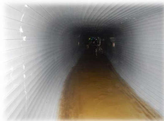
管更生工法による改築の例
