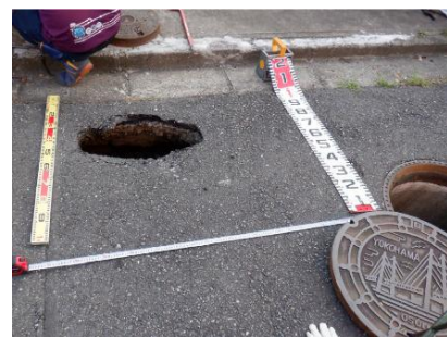
取付管破損による道路陥没
