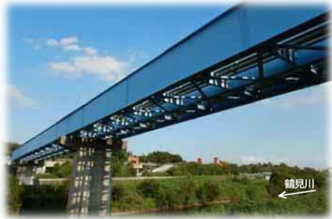
水管橋の耐震化（新羽ポンプ場）
