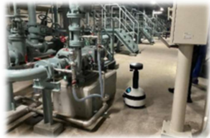
AGVでの自動巡回点検実験の様子
