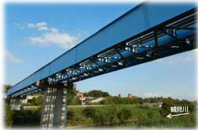
水管橋の耐震化（新羽ポンプ場）
