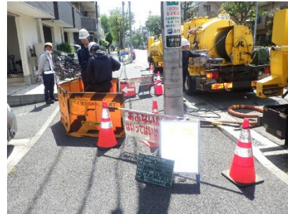
下水道管清掃状況
