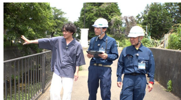
報道で紹介された点検の様子 © t v k ハマナビより
