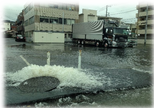
浸水被害状況（平成26年） （戸塚小学校南口交差点付近）
