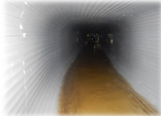
管更生工法による改築の例
