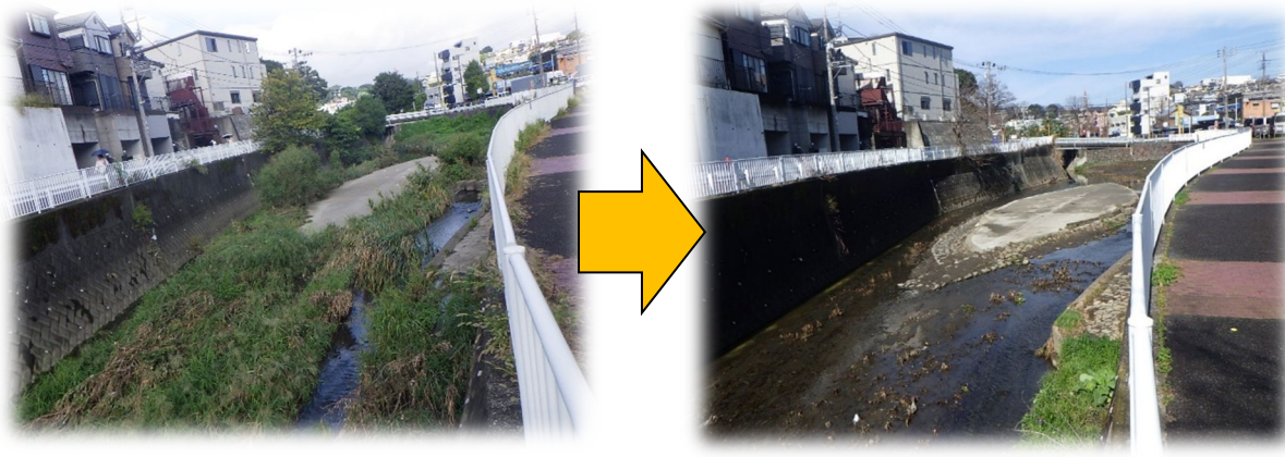
河道内の土砂堆積撤去（今井川）前後
