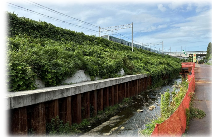
河川改修（護岸整備）（今井川）
