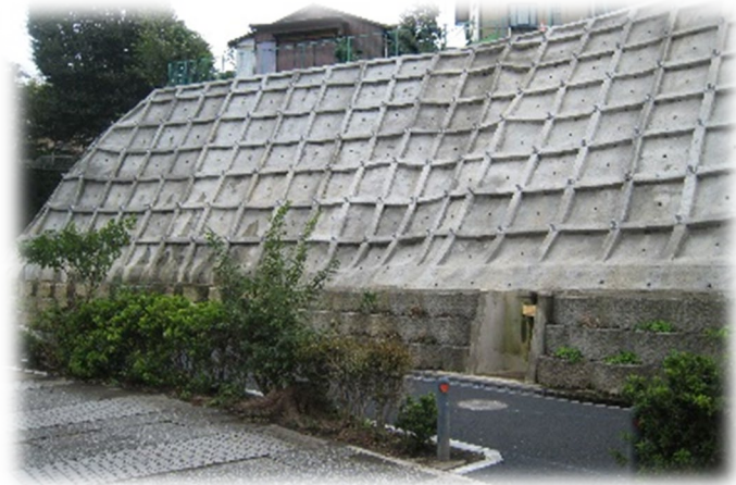
がけ安全対策事業実施箇所（三ツ沢せせらぎ緑道）
