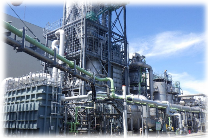
汚泥燃料化施設
