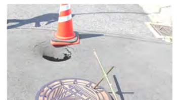
取付管破損による道路陥没
