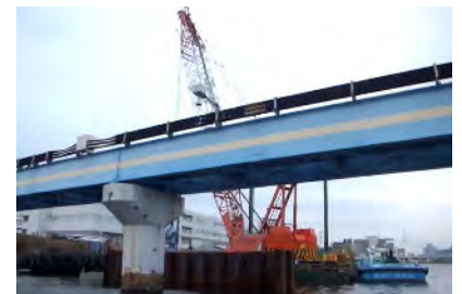
水管橋の耐震化（末吉ポンプ場）
