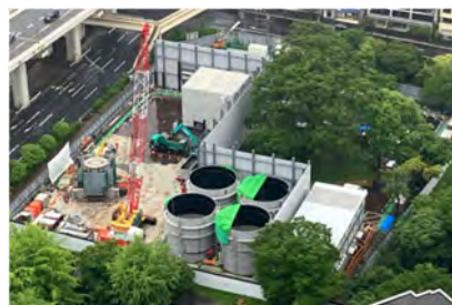
雨水幹線発進立坑築造工 (神奈川公園)
