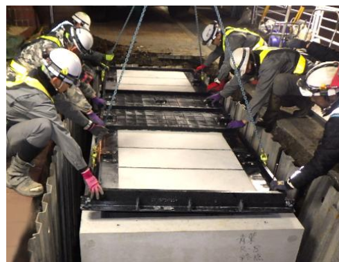
特殊部設置状況
