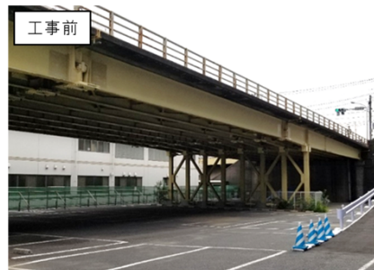
矢向第一陸橋（鶴見区）：耐震工事（擁壁化）の状況
