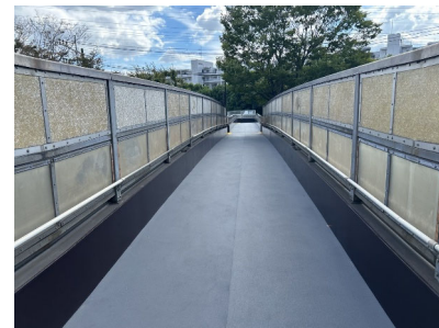
川上町歩道橋(戸塚区):橋面舗装補修
