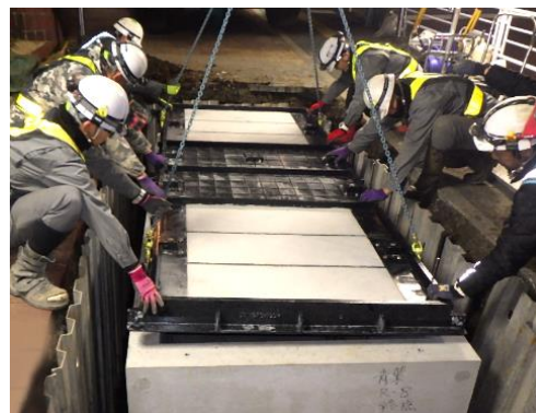
特殊部設置状況
