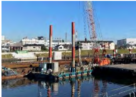
河川工事状況(橋脚を施工中)
