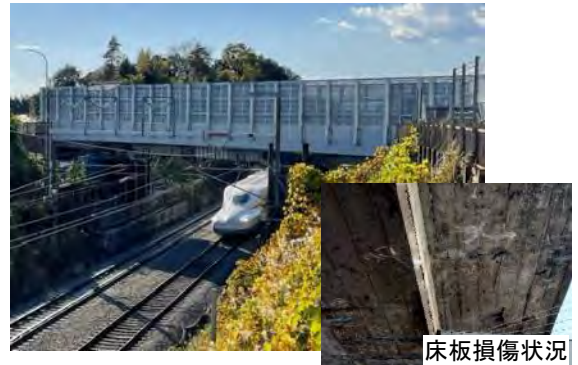
計画的な補修: 第1柳明橋(泉区)
