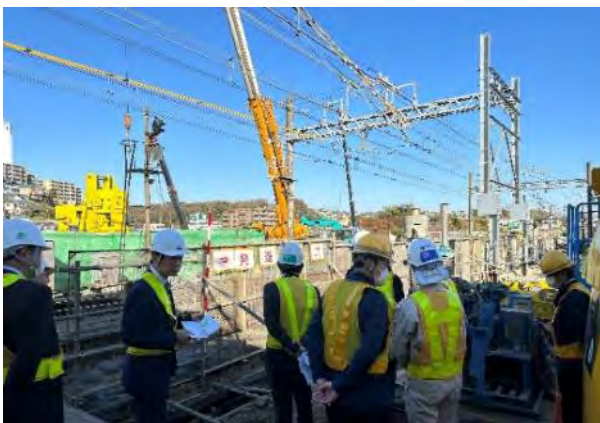
有識者による現場視察(発進立坑部)
