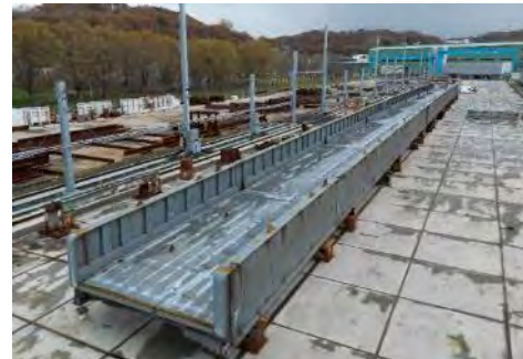
桁部製作状況
