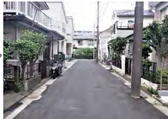
私道整備助成実施後(港北区)
