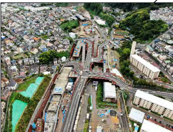
（仮称）公田IC築造工事（栄区公田町）公田小学校下交差点付近
