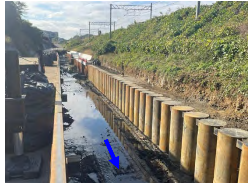
護岸改修、橋梁架替え、用地補償 (今井川：保土ヶ谷区榎太坂一丁目)
