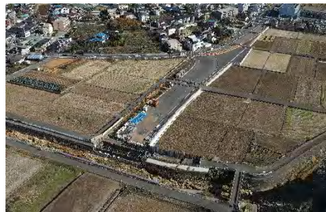
奈良川を横断する橋梁工事
