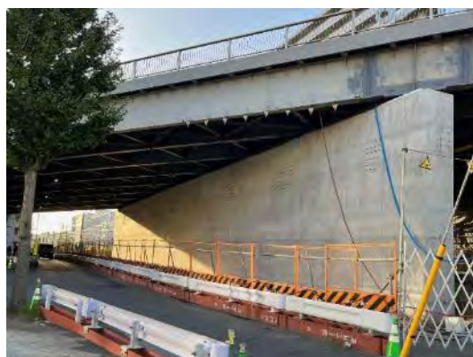
耐震補強工事:新横浜陸橋(港北区)
