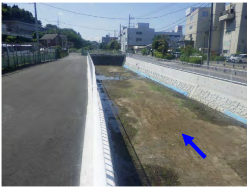
護岸改修、暫定貯留部整備、橋梁新設 (帷子川：旭区川井本町)
