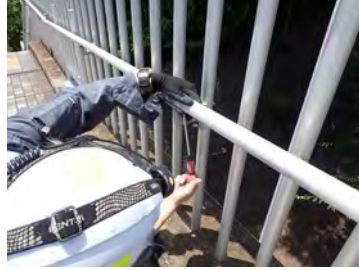
手すりの点検と応急処置 ふじ歩道橋(保土ヶ谷区)
