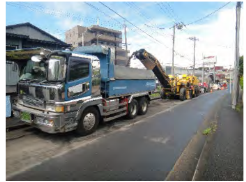
舗装修繕工事の状況(旭区)
