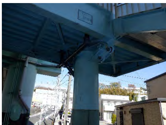
峰沢町歩道橋(保土ヶ谷区):横変位装置 令和5年7月完成
