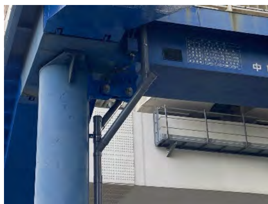
錦町第三歩道橋(中区):落橋防止装置 令和5年7月完成
