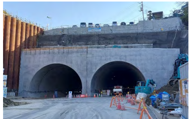
桂町トンネル工事
