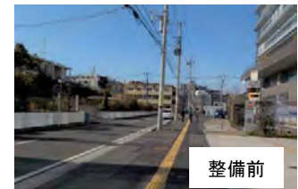
無電柱化の状況 (港南区役所)
