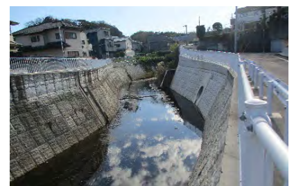
河川改修 (護岸整備: 日野川)
