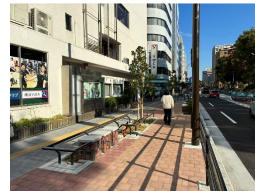
みなと大通りの歩道拡幅状況
