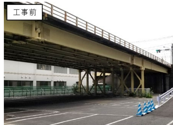
矢向第一陸橋（鶴見区）：耐震工事（擁壁化）の状況
