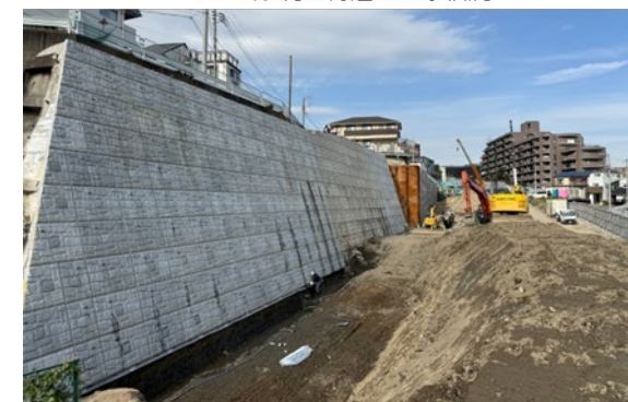
環状4号線側の擁壁工事状況
