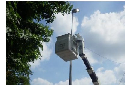
道路照明灯の点検
