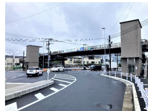
国道1号（不動坂工区）
