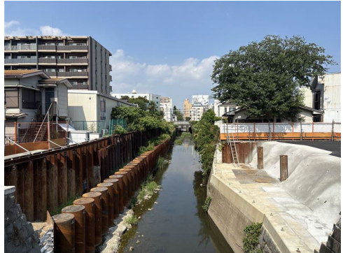
国道1号【保土ヶ谷橋工区】(保土ヶ谷区)
