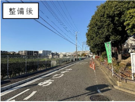
【泉区】市道新橋第276号線
