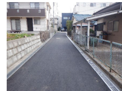
私道整備助成実施後（都筑区）
