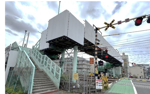
古市場人道橋(鶴見区)：補修工事
