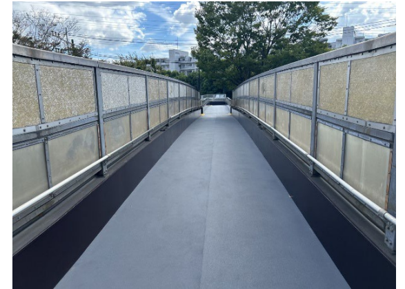
川上町歩道橋(戸塚区):橋面舗装補修
