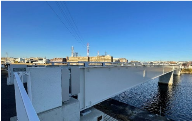
鶴見川人道橋(鶴見区)の全景
