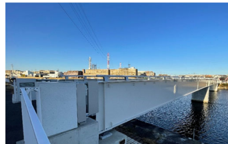
鶴見川人道橋(鶴見区)の全景
