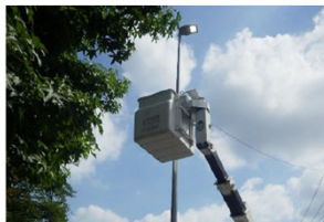
道路照明灯の点検
