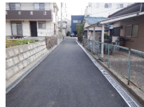
私道整備助成実施後(都筑区)
