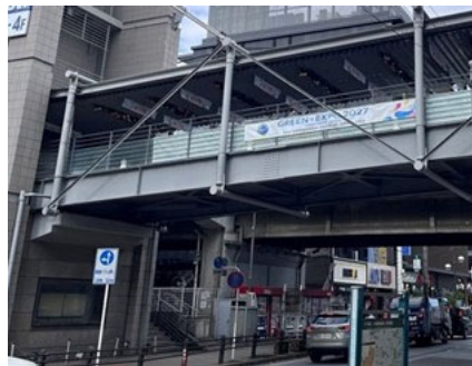
青葉台駅前第一歩道橋（青葉区）： 桁を支える下部工の台座部を拡幅
