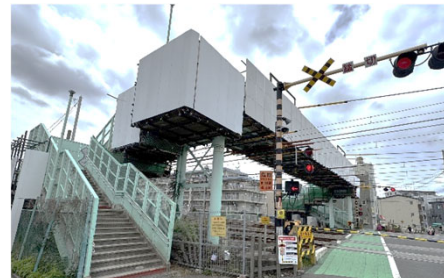
古市場人道橋(鶴見区):補修工事
