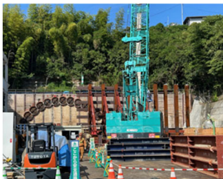
施工状況(第2トンネル 山谷交差点付近)
