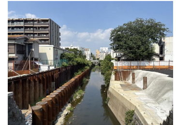
国道1号【保土ヶ谷橋工区】(保土ヶ谷区)
