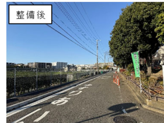
【泉区】市道新橋第276号線
