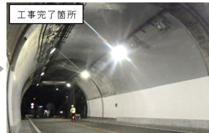
相武隧道(金沢区):鋼板内巻工法による補強を実施
