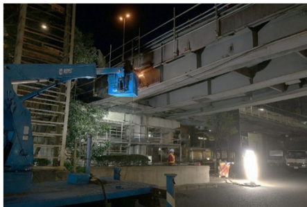
横浜駅東口歩道橋(西区):化粧パネルの撤去
