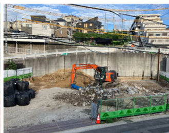
施工状況(第2トンネル 中間明かり部付近)
