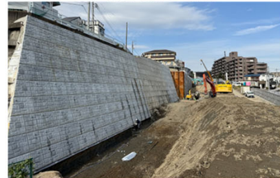
環状4号線側の擁壁工事状況
