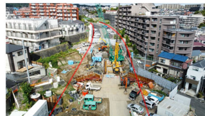
トンネル坑口付近の工事状況
