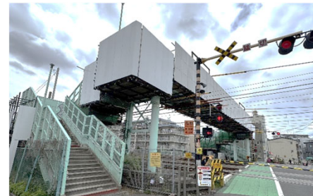
古市場人道橋（鶴見区）：補修工事
