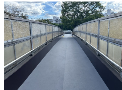
川上町歩道橋(戸塚区):橋面舗装補修
