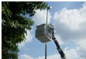
道路照明灯の点検
