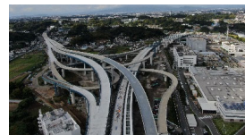
横浜環状南線・横浜湘南道路 (高架橋整備：(仮)栄IC・JCT)
