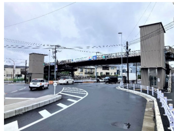
国道1号（不動坂工区）
