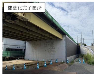
矢向第一陸橋（鶴見区）：耐震工事（擁壁化）の状況
