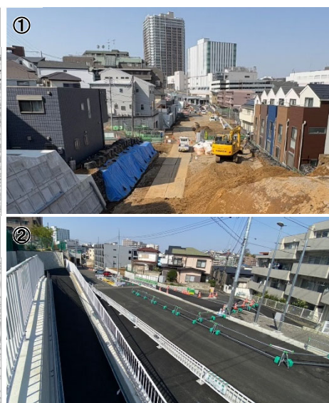
工事が進む鴨居上飯田線
