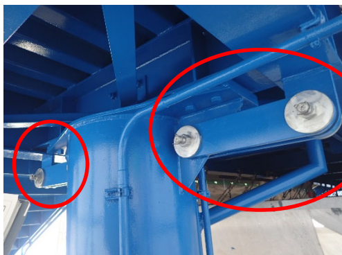
中野町橋歩道橋（栄区）：横変位制限装置 5年12月完成
