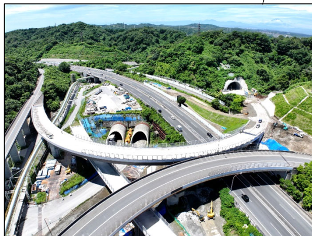
釜利谷JCT工事の状況
