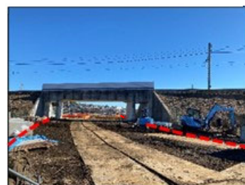
②工事が進む川崎町田線
