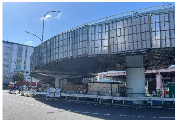
新子安橋(神奈川区): 桁、床板補修工事
