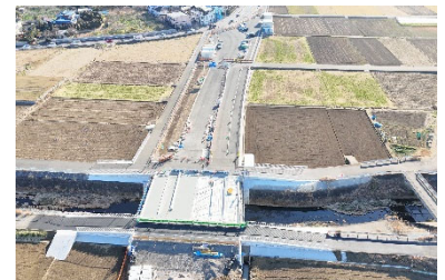
都市計画道路整備事業 (橋梁工: 川崎町田線)
