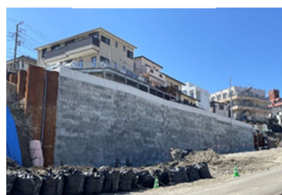
②トンネル坑口付近の擁壁工事
