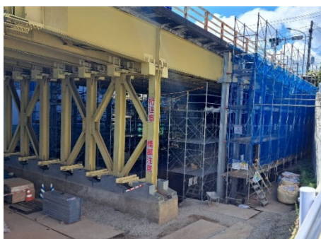
矢向第一陸橋（鶴見区）：耐震化工事の状況
