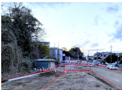
山下長津田線【鴨居地区】(緑区)
