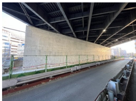
新横浜陸橋（港北区）：橋脚の壁化の状況
