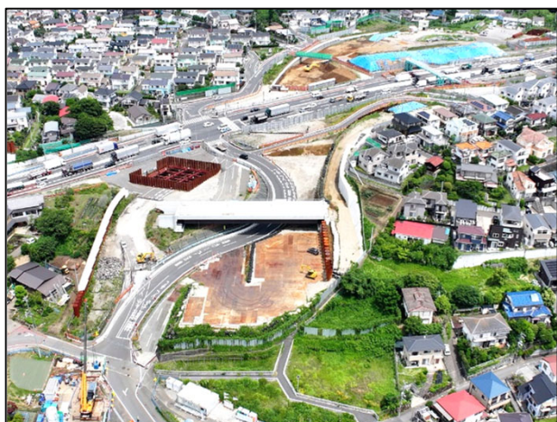
（仮）戸塚IC工事の状況
