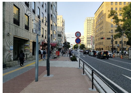
みなと大通りの歩道拡幅状況
