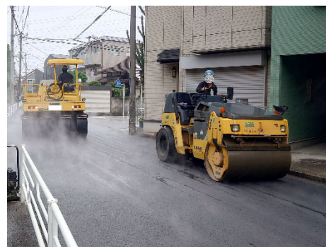
舗装修繕工事の状況(港北区)
