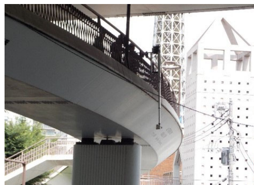
ボールカメラによる点検 フランス橋 (中区)
