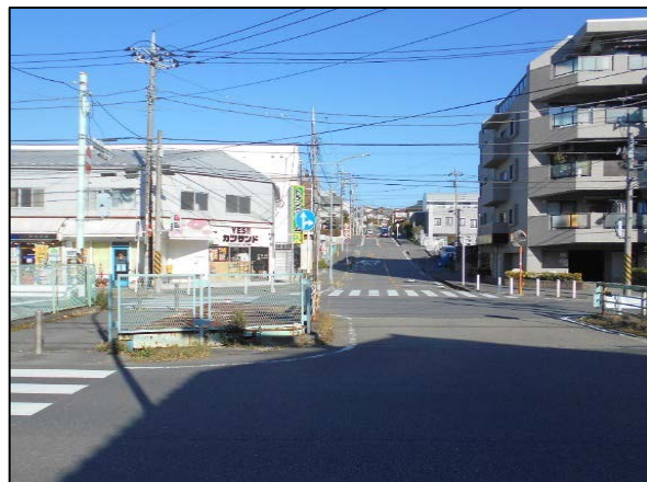
交差点改良・右折レーン設置 県道横浜生田【平原橋交差点】(青葉区)
