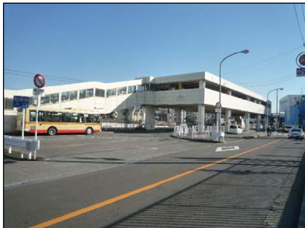
戸塚駅西口第2バスセンターの拡張 市道矢部第281号線(戸塚区)
