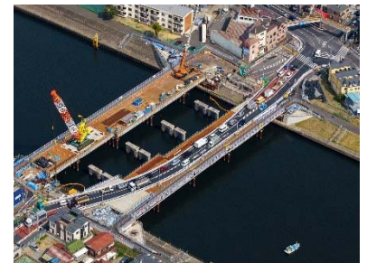
橋梁の架け替え(末吉橋)
