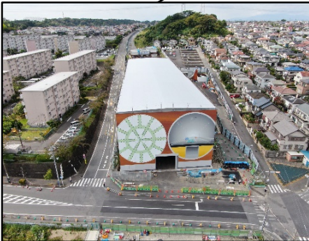
桂台トンネル工事 (栄区上郷町)
