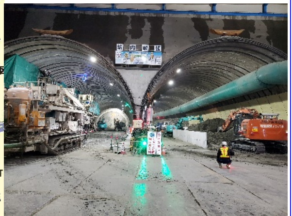
桂町トンネル工事
