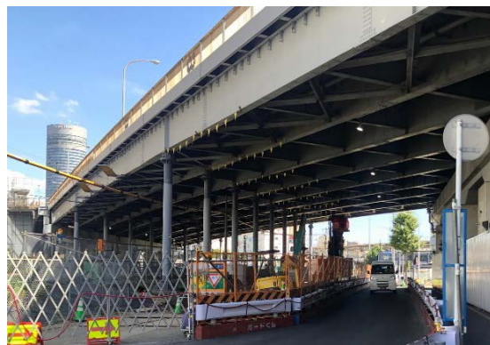
新横浜陸橋(港北区):耐震補強工事
