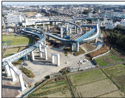
栄IC・JCT築造工事 (栄区田谷町)
