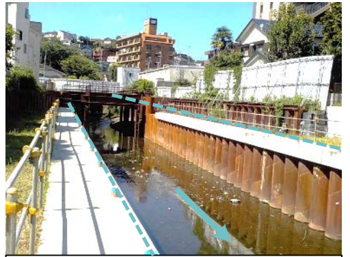
護岸改修 (今井川：保土ヶ谷区岩井町)
