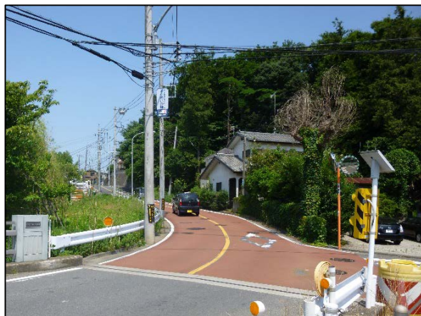
歩道設置 市道下瀬谷第438号線(瀬谷区)
