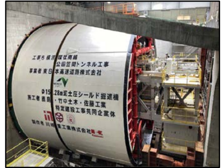
公田笠間トンネル工事 (栄区飯島町)
