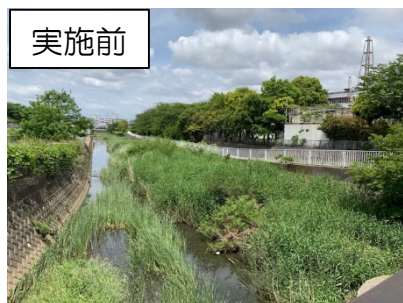
樹木伐採、除草、堆積土砂の掘削 (平戸永谷川)
