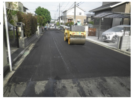
舗装修繕工事の状況(泉区)
