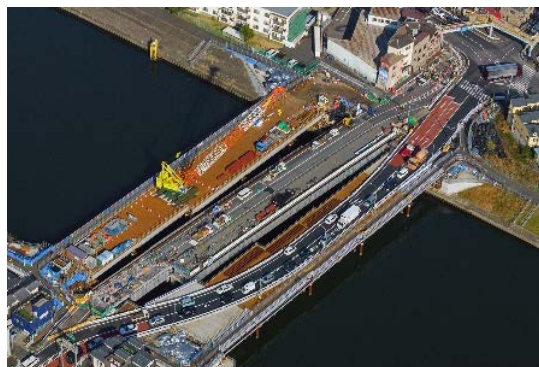
老朽橋架け替え:末吉橋(鶴見区) (令和3年12月時点の現場状況)
