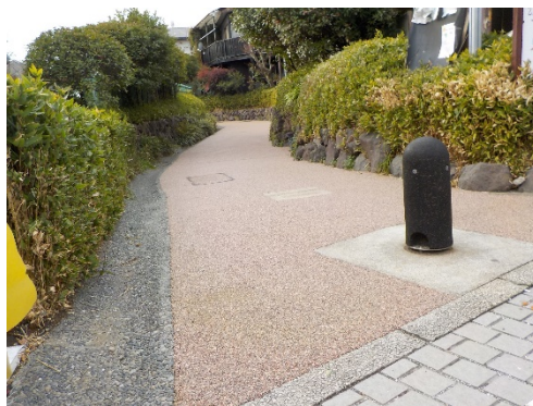
舗装の改修 (神奈川区:水と緑豊かな安らぎのルート)
