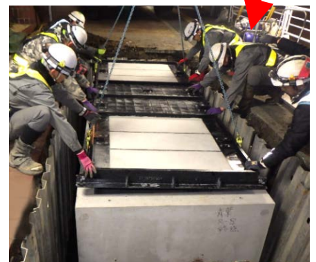
特殊部の設置状況
