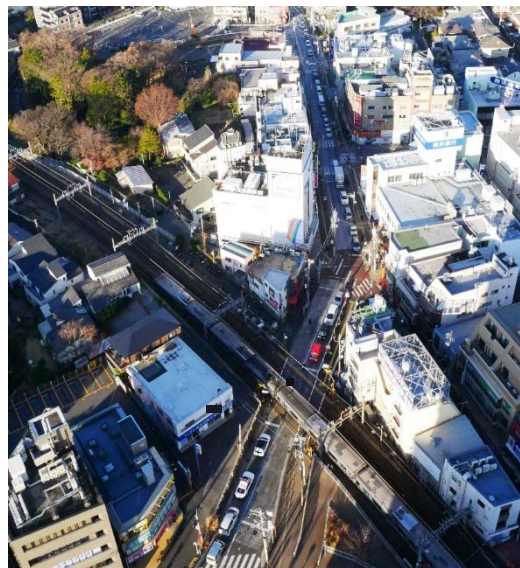
踏切遮断による周辺道路渋滞状況（鶴ヶ峰駅前の水道道）
