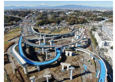
横浜環状南線・横浜湘南道路の整備 (仮称栄IC・JCT)
