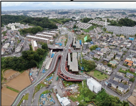
公田IC築造工事 (栄区公田町)
