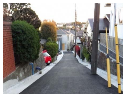
私道整備助成実施後(港北区)
