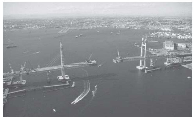
建設中のベイブリッジ 1989年1月頃 斜張橋としては世界最大だった。横浜市史資料室所蔵・広報課写真資料
