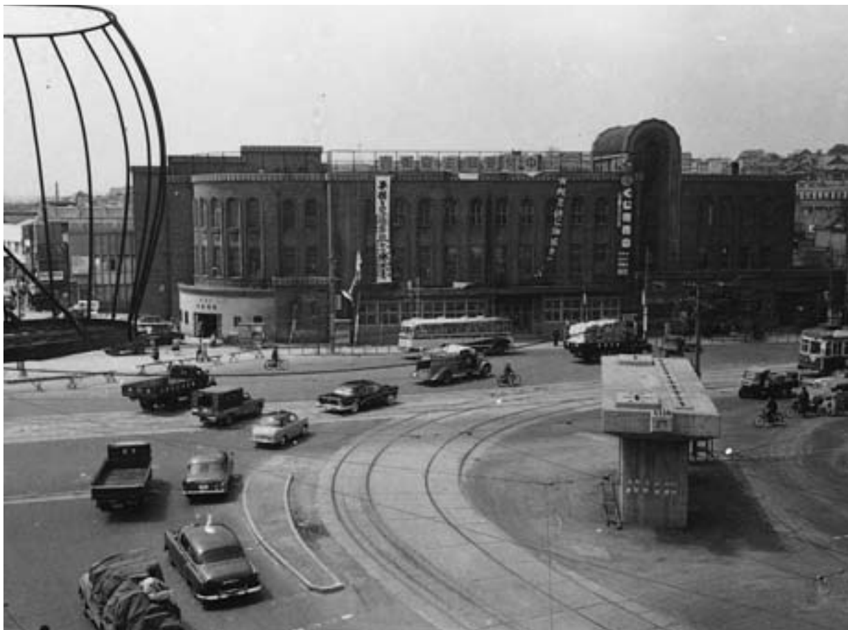
桜木町1丁目横浜興産館時代の中区役所、手前の橋脚は工事中の国鉄根岸線 1961年4月 広報課写真資料(横浜市史資料室所蔵)
