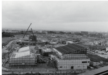
港北ニュータウン、北部工場余熱利用施設建設中(港北区) 1984年01月12日 9587
