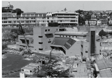
完成間近の市民防災センター(神奈川区) 1983年03月03日 9387
