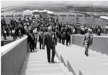
横浜港シンボルタワー(仮称)竣工(中区) 1986年07月 10192
