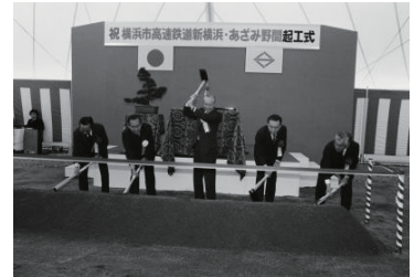
横浜市高速鉄道新横浜・あざみ野間起工式(港北区) 1987年02月28日 10317
