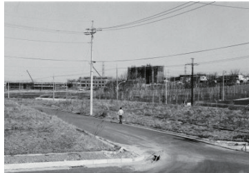
港北ニュータウン(港北区) 1983年03月03日 9396
