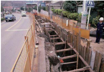
下水道工事(旭区) 1984年03月 9653
