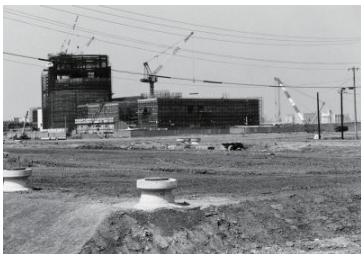
建設進む横浜美術館(西区) 1987年04月 10370
