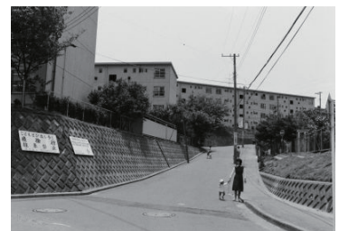
住宅=南長津田団地(緑区) 1984年05月11日 9708
