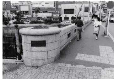
建替えられる長者橋の橋柱(中区) 1984年10月02日 9779
