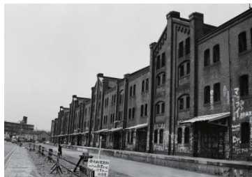
落書きされた赤レンガ倉庫(中区) 1986年06月 10174
