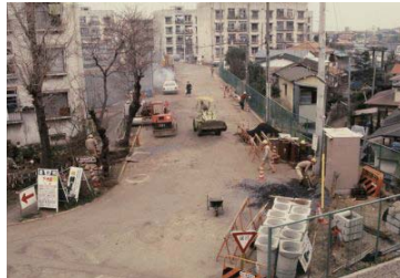
下水道工事(西区) 1984年03月 9655
