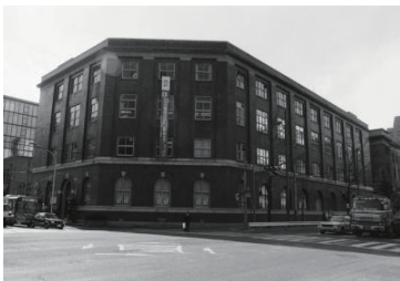
関内地区の建築物(中区) 1987年02月 10330
