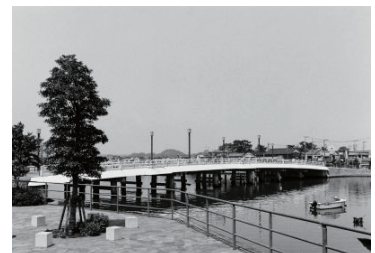
夕照橋(金沢区) 1987年05月 10403
