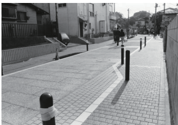
完成間近の三ツ沢せせらぎ緑道(神奈川区) 1987年05月 10398
