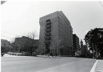
関内地区の建築物(中区) 1987年02月 10326
