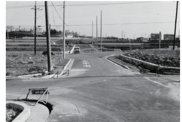
港北ニュータウン(港北区) 1983年03月03日 9397
