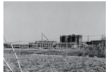
港北ニュータウン(港北区) 1983年03月03日 9400
