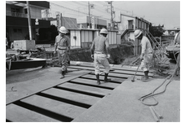
阿久和川改修工事(戸塚区) 1984年10月05日 9782
