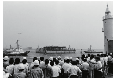
ベイブリッジの橋脚を支えるコンクリート製バージ、海上輸送(中区) 1983年08月09日 9486
