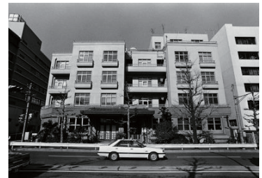
関内地区の建築物(中区) 1987年02月 10319
