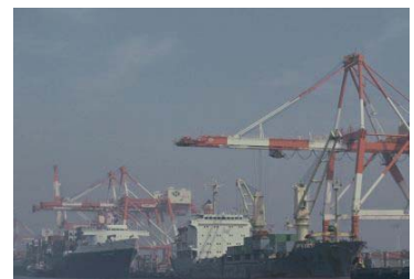
ガントリークレーン 1987年10月 10555
