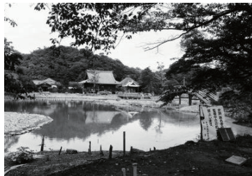
庭園再現工事進む称名寺(金沢区) 1987年09月 10542
