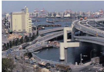
高速道路(横浜地方合同庁舎から)(中区) 1984年04月 9693
