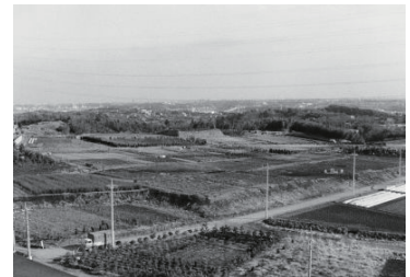
港北ニュータウン(港北区) 1983年03月03日 9403
