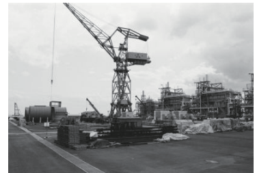
三菱重工横浜造船所新工場(金沢区) 1983年03月18日 9418
