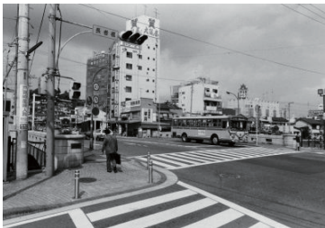
建替えられる長者橋の橋柱(中区) 1984年10月02日 9778
