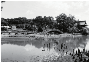
庭園再現工事進む称名寺(金沢区) 1987年09月 10541
