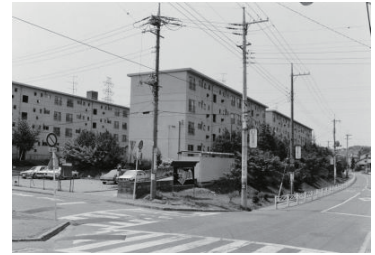
住宅=南長津田団地(緑区) 1984年05月11日 9705
