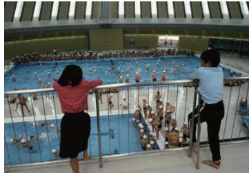
北部工場・余熱利用施設、温水プール(緑区) 1984年11月06日 9795
