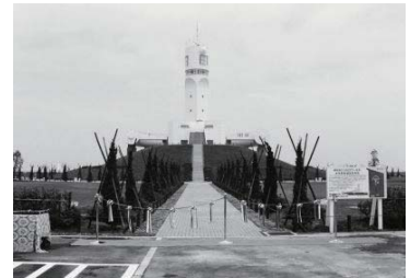
横浜港シンボルタワー(仮称)竣工(中区) 1986年07月 10191
