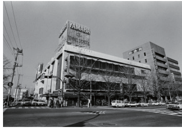
関内地区の建築物(中区) 1987年02月 10324
