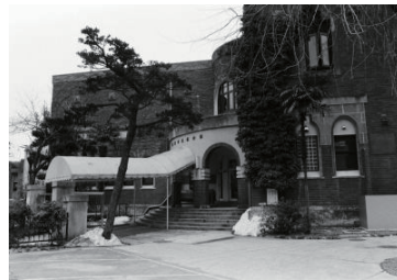
老松会館外観(西区) 1984年02月15日 9622
