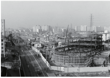
こども科学館(建設中) (磯子区) 1983年02月15日 9386
