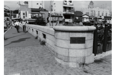
建替えられる長者橋の橋柱(中区) 1984年10月02日 9777
