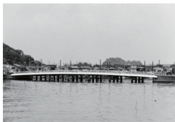
夕照橋(金沢区) 1987年05月 10405
