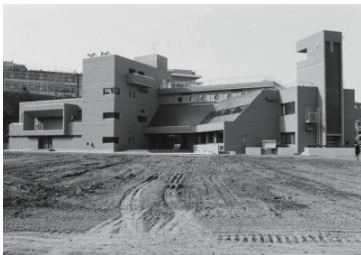
市民防災センター(神奈川区) 1983年04月11日 9434
