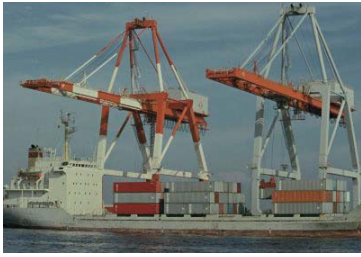
ガントリークレーン 1987年10月 10556
