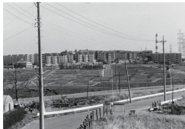
港北ニュータウン(港北区) 1983年03月03日 9399
