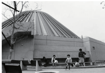
北部工場・余熱利用施設、温水プール(緑区) 1984年11月06日 9799
