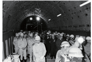
市営地下鉄3号線、横浜-新横浜間の導坑貫通(港北区) 1983年01月31日 9377
