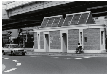
戸外の身障者用トイレ(中区) 1986年05月16日 10134
