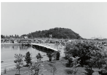
夕照橋(金沢区) 1987年05月 10404
