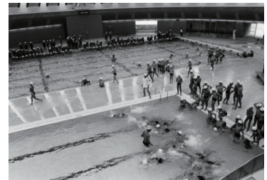
北部工場・余熱利用施設、温水プール(緑区) 1984年11月06日 9801
