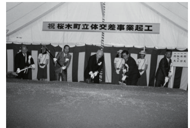
祝桜木町立体交差事業起工式(中区) 1986年07月15日 10187
