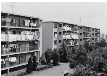
住宅=南長津田団地(緑区) 1984年05月11日 9706
