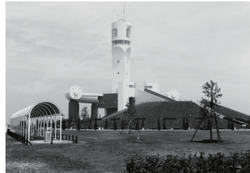
横浜港シンボルタワー(仮称)竣工(中区) 1986年07月 10193
