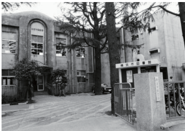
横浜市図書館外観(西区) 1984年02月15日 9621
