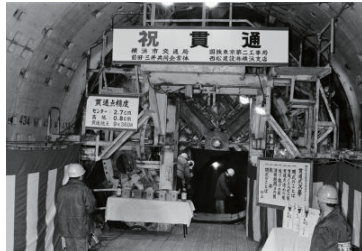
市営地下鉄3号線、横浜-新横浜間の導坑貫通(港北区) 1983年01月31日 9376
