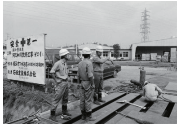
阿久和川改修工事(戸塚区) 1984年10月05日 9781
