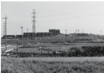
港北ニュータウン(港北区) 1983年03月03日 9398
