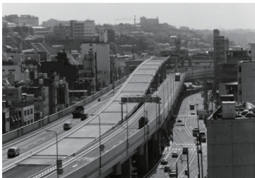
高速道路(横浜地方合同庁舎から)(中区) 1984年04月 9695
