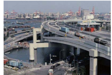
高速道路(横浜地方合同庁舎から)(中区) 1984年04月 9694
