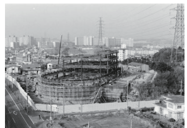
こども科学館(建設中)(磯子区) 1983年02月15日 9385
