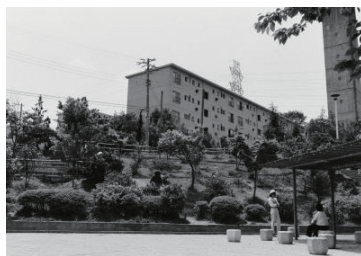
住宅=南長津田団地(緑区) 1984年05月11日 9707
