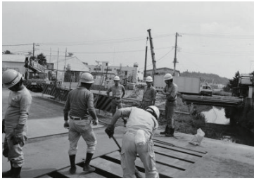
阿久和川改修工事(戸塚区) 1984年10月05日 9780
