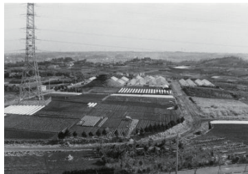
港北ニュータウン(港北区) 1983年03月03日 9402
