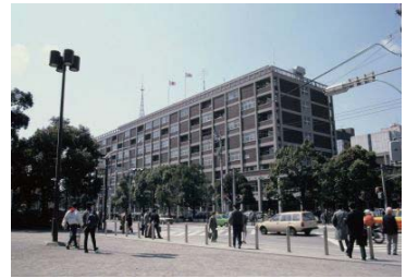
横浜市庁舎外観(中区) 1986年03月26日 10066
