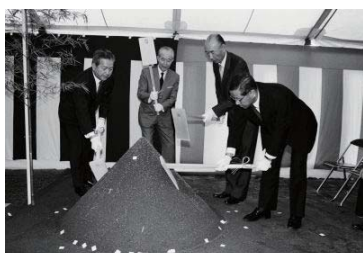
新横浜イベントホール(仮称)起工式(港北区) 1987年05月28日 10413
