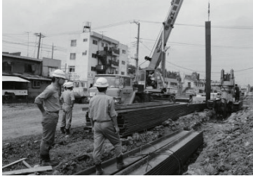
阿久和川改修工事(戸塚区) 1984年10月05日 9783
