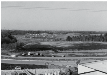
港北ニュータウン(港北区) 1983年03月03日 9401
