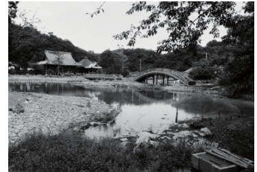
庭園再現工事進む称名寺(金沢区) 1987年09月 10540
