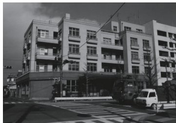
関内地区の建築物(中区) 1987年02月 10331
