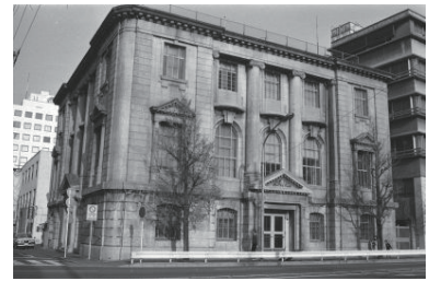
関内建築散歩、警友病院別館(中区) 1980年12月 8304
