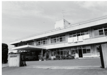
岩井ホーム外観(保土ヶ谷区) 1982年09月14日 9286
