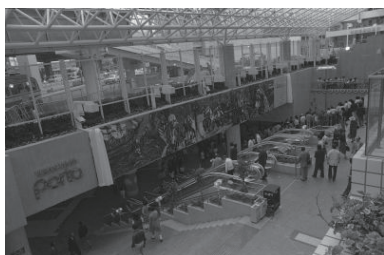
ポルタシンボルゾーン完成(西区) 1981年06月10日 8568
