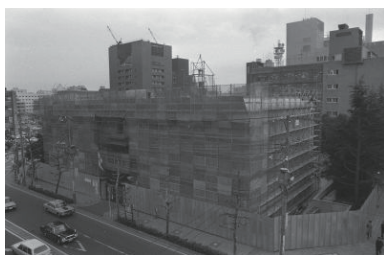
開港資料館建設中(中区) 1981年01月 8469
