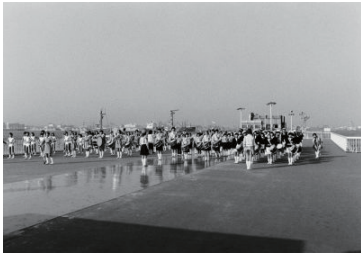
大棧橋改修工事完成式(中区) 1982年03月11日 8942
