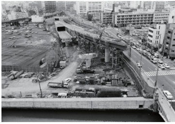
高速道路工事(中区) 1982年04月02日 9032
