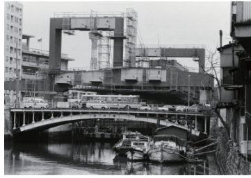
高速道路工事(中区) 1982年04月02日 9035
