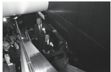
車いすリフトエスカレーター竣工(西区) 1981年11月20日 8797
