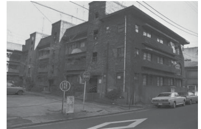
山下町アパート(中区)
