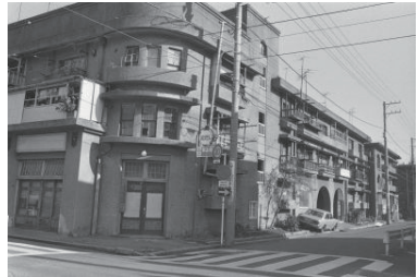
山下町アパート(中区)
