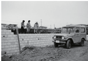
港北ニュータウン(港北区) 1982年01月11日 9026
