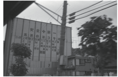
地下鉄3号線工事現場(神奈川区) 1981年11月19日 8789
