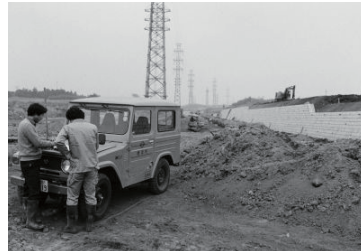
港北ニュータウン(港北区) 1982年01月11日 9024
