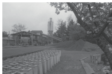
川口製糸跡コンクリート工場(瀬谷区) 1981年04月 8508
