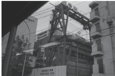
地下鉄3号線工事現場(神奈川区) 1981年11月19日 8790
