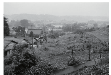
市街化調整区域内の宅地(緑区) 1982年09月07日 9266
