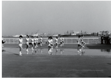
大棧橋改修工事完成式(中区) 1982年03月11日 8943
