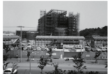
南部地域総合病院建設中(港南区) 1982年05月13日 9117
