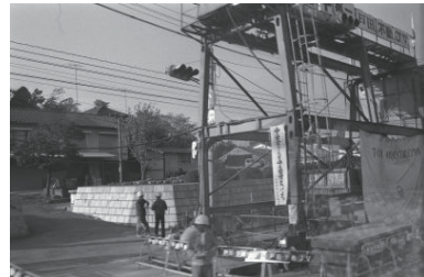
地下鉄3号線工事現場(神奈川区) 1981年11月19日 8791
