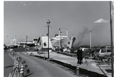
大栈橋入り口道路の歩道拡張工事(中区) 1982年03月03日 8931
