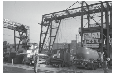
地下鉄3号線工事現場(神奈川区) 1981年11月19日 8792
