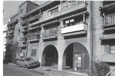
山下町アパート(中区)
