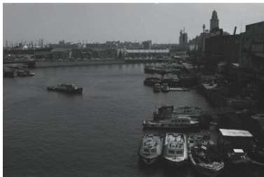
横浜港、万国橋界限(中区) 1980年10月27日 8210
