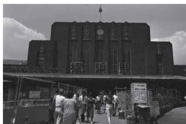
駅空間(横浜駅舎) (西区) 1978年07月 7513
