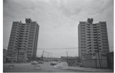
金沢地先埋立地に高層住宅建設(並木団地) (金沢区) 1978年04月10日 7425
