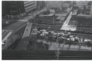
高速道路工事中(市庁舎屋上から)(中区) 1977年12月23日 7213
