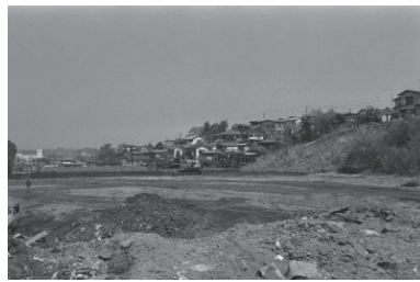
長坂谷埋立処分地 1979年04月13日 7748
