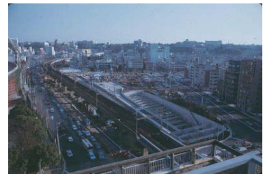
高速道路工事中(市庁舎屋上から)(中区) 1978年01月 7250
