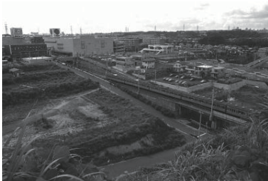
根岸線港南台駅付近(港南区) 1978年07月 7531
