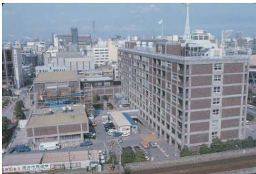
横浜市庁舎(教育文化センター屋上から) (中区) 1978年04月05日 7258
