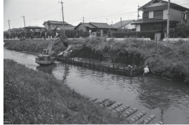
境川流域、護岸工事(瀬谷区) 1977年07月 6853
