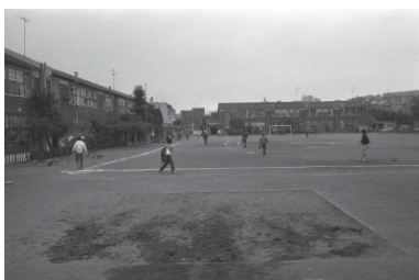
木造校舎(中村小学校)(南区) 1979年03月10日 7732
