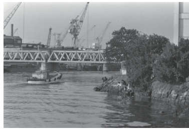
大岡川、港1号橋梁(中区) 1980年11月 8295
