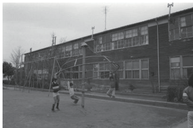
木造校舎(中村小学校)(南区) 1979年03月10日 7729
