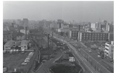
高速道路工事中(中区) 1978年02月13日 7379
