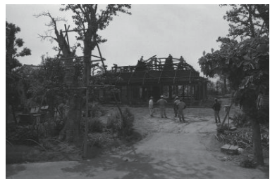
草屋根解体(日野峰)(港南区) 1979年05月 7789
