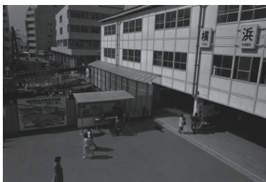
横浜駅東口改修工事、仮駅舎(西区)
