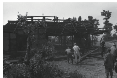
草屋根解体(日野峰)(港南区) 1979年05月 7790
