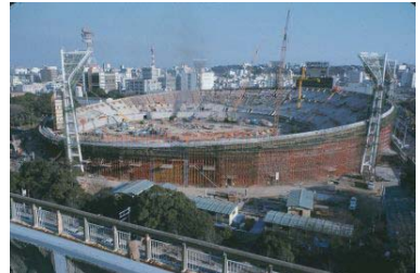
横浜スタジアム工事中(市庁舎屋上から)(中区) 1978年01月 7252
