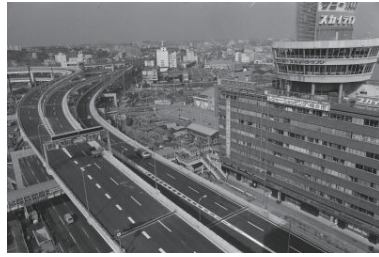
高速神奈川1号横羽線、横浜駅前スカイビル(西区) 1978年03月08日 7393
