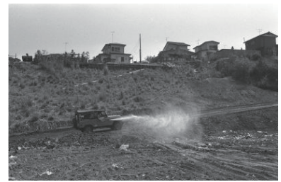
長坂谷埋立処分地 1979年04月13日 7749
