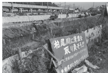
柏尾川護岸工事(戸塚区) 1977年07月 6869
