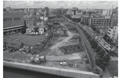
高速道路狩場線工事(中区) 1978年07月 7535
