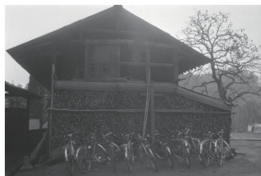
長屋門 (新治町、奥津邸) (緑区) 1977年12月 7195
