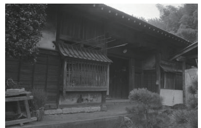
長屋門 (新治町、奥津邸) (緑区) 1977年12月 7193
