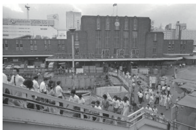
横浜駅東口駅舎(西区) 1978年07月 7503
