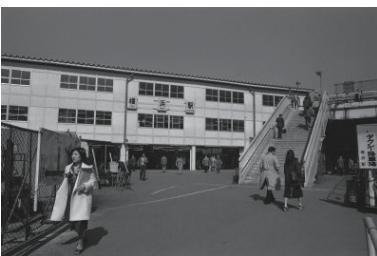
横浜駅東口改修工事、仮駅舎(西区)
