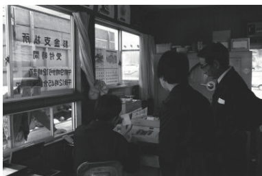
長坂谷埋立処分地、料金支払い所 1979年04月13日 7745
