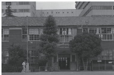
木造校舎(中村小学校)(南区) 1979年03月10日 7730
