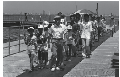
本牧海づり施設竣工(中区) 1978年07月28日 7494
