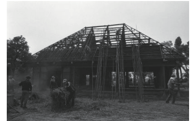
草屋根解体(日野峰)(港南区) 1979年05月 7788
