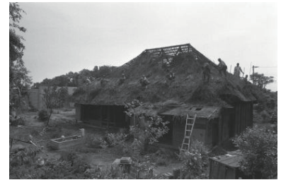
草屋根解体(日野峰)(港南区) 1979年05月 7782
