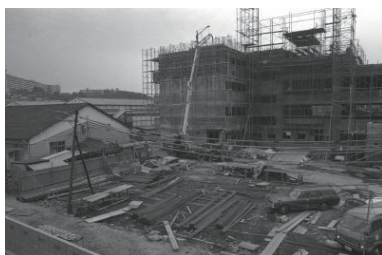
鉄筋校舎に建て替え(神大寺小学校)(神奈川区) 1979年03月10日 7733
