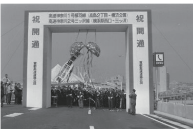
高速神奈川1号横羽線・2号三ツ沢線開通(西区) 1978年03月07日 7388
