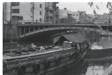
中村川、西の橋(中区) 1978年05月 7448
