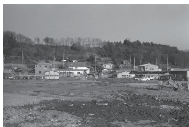
緑下水処理場建設現場から佐江戸城址江をみる(緑区) 1979年01月 7680
