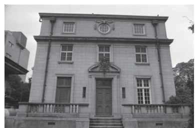
旧イギリス領事館(バルコニー、壁面)(中区) 1977年10月 7038
