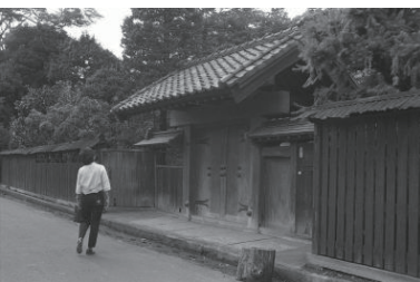
旧東海道保土ヶ谷周辺(保土ヶ谷区) 1978年10月10日 7589
