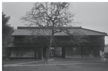
長屋門 (新治町、奥津邸) (緑区) 1977年12月 7192
