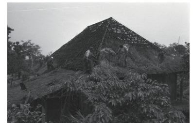
草屋根解体(日野峰)(港南区) 1979年05月 7785
