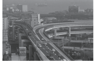
高速道路横羽線(西区) 1978年03月08日 7397
