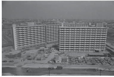
金沢地先埋立地に高層住宅建設(並木団地) (金沢区) 1978年04月10日 7420
