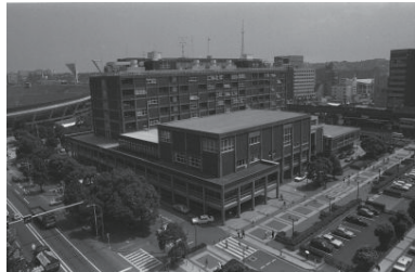
横浜市庁舎(中区) 1980年06月 8017
