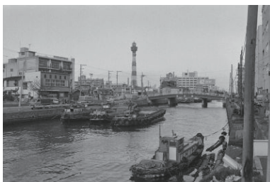
堀川、〔マリンタワー〕(中区) 1977年12月19日 7208
