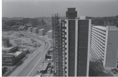
金沢地先埋立地に高層住宅建設(並木団地) (金沢区) 1978年04月10日 7424
