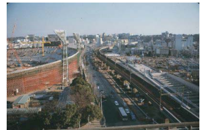
高速道路工事中(市庁舎屋上から)(中区) 1978年01月 7251
