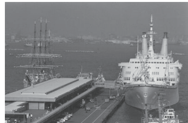
大栈橋(中区) 1977年11月10日 7142
