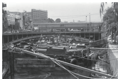
中村川、西の橋(中区) 1978年05月 7447
