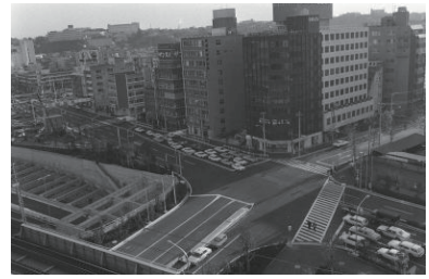
高速道路工事中(市庁舎屋上から)(中区) 1977年12月23日 7214
