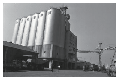
倉庫いろいろ、新港倉庫(中区) 1977年10月 7095
