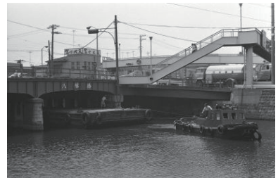
掘割川、八幡橋(磯子区) 1978年05月 7442
