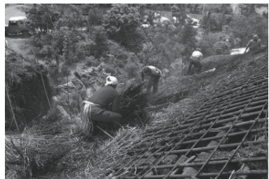
草屋根解体(日野峰)(港南区) 1979年05月 7783
