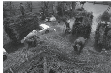
草屋根解体(日野峰)(港南区) 1979年05月 7784
