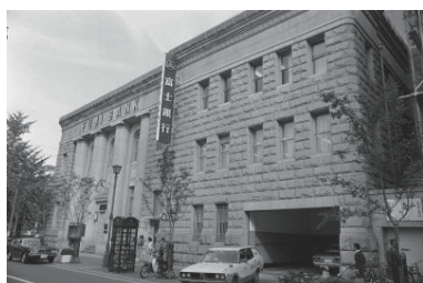
建築物の外観装飾とデザイン、富士銀行横浜支店(中区) 1977年10月 7030
