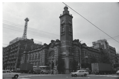
建築物の外観装飾とデザイン、開港記念会館(中区) 1977年10月 6992
