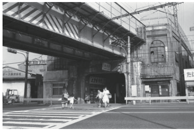
鶴見線国道駅前(鶴見区) 1978年07月 7542
