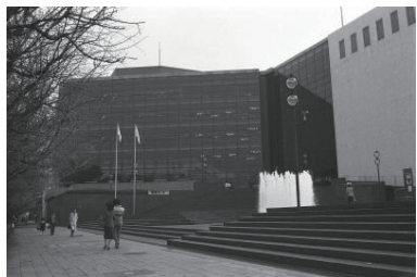
県民ホール(中区) 1979年11月 7869
