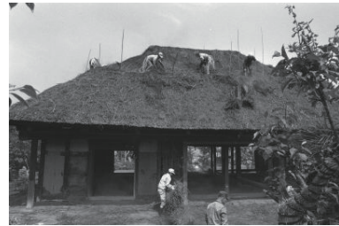
草屋根解体(日野峰)(港南区) 1979年05月 7781
