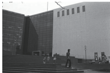
県民ホール(中区) 1979年11月 7870
