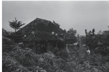
草屋根解体(日野峰)(港南区) 1979年05月 7786
