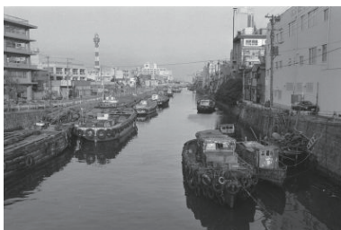
堀川、〔マリンタワー〕(中区) 1977年12月19日 7209
