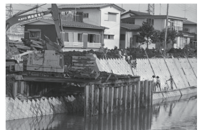
柏尾川護岸工事(戸塚区) 1977年07月 6870
