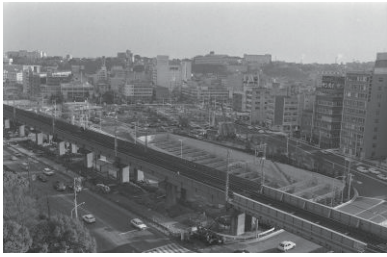
高速道路工事中(市庁舎屋上から)(中区) 1977年12月23日 7212
