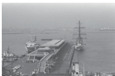
大栈橋(中区) 1980年05月29日 7962
