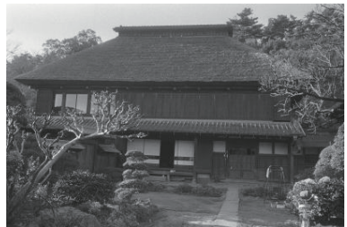
薬葺き屋根母屋(獅子ヶ谷、横溝邸)(鶴見区) 1978年01月 7362
