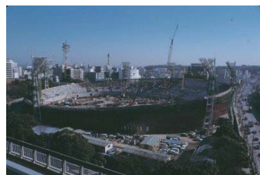
ヨコハマスタジアム工事中(市庁舎屋上から) (中区) 1977年12月 7247
