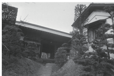
長屋門 (新治町、奥津邸) (緑区) 1977年12月 7194
