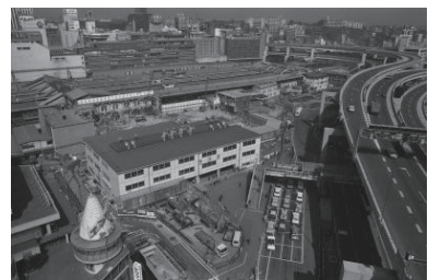
横浜駅東口改修工事、仮駅舎周辺(鳥瞰)(西区)
