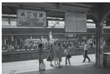
駅空間(横浜駅ホーム) (西区) 1978年07月 7509
