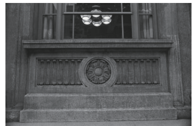
ファースト・シティバンク(窓周辺)(中区) 1977年10月 7029
