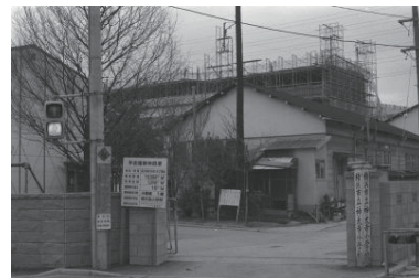
鉄筋校舎に建て替え(神大寺小学校)(神奈川区) 1979年03月10日 7731
