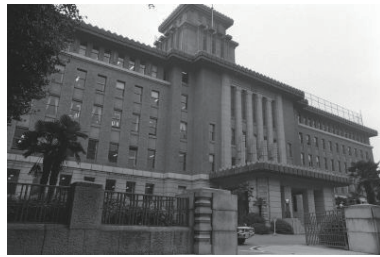
日本大通の建築物（神奈川県庁）(中区) 1977年10月 7076
