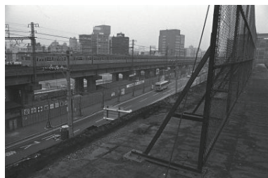
取り壊される平和球場(中区) 1977年02月14日 6725
