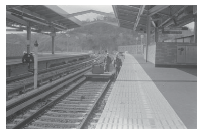
市営地下鉄工事進む=上永谷駅(港南区) 1976年04月05日 6337
