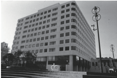
産業貿易センタービル(中区) 1976年01月 6268
