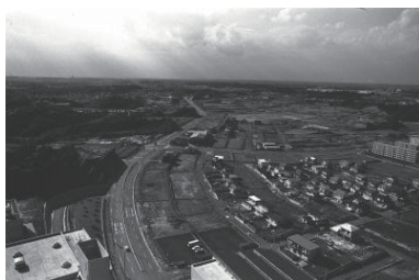
港南工場周辺、宅地造成(港南区) 1974年09月15日 5824
