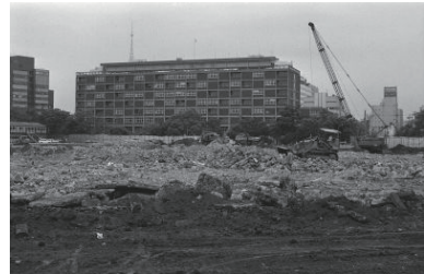
取り壊された平和球場(中区) 1977年04月26日 6752
