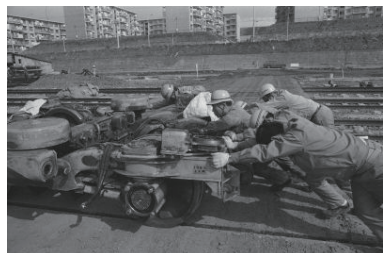
市営地下鉄工事進む=上永谷駅(港南区) 1976年04月05日 6350
