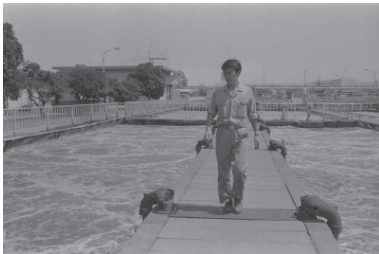
中部下水処理場(中区) 1975年08月14日 6188
