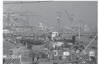
道路工事(西区) 1975年12月02日 6241
