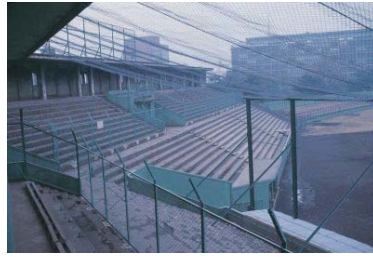
取り壊される平和球場(中区) 1977年01月 7226
