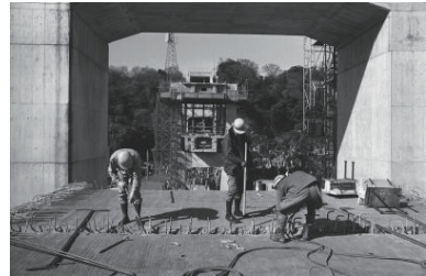
高速道路三ツ沢線、工事中(西区) 1977年01月24日 6694
