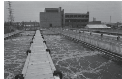
戸塚第二下水処理場竣工(戸塚区) 1974年06月07日 5701
