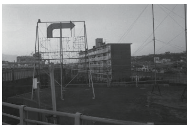
工場解体? 1975年11月07日 6221
