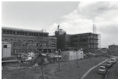
学校建設工事(保土ヶ谷区) 1977年02月05日 6714
