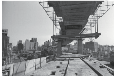
高速道路三ツ沢線、工事中(西区) 1977年01月24日 6693
