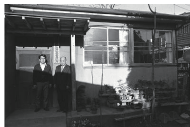
金沢区役所富岡吏員派出所(金沢区) 1976年01月13日 6266
