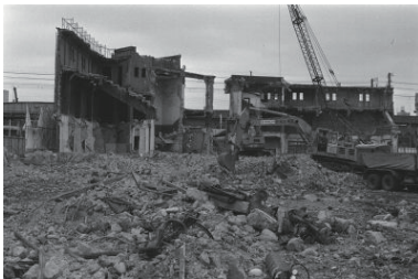
取り壊された平和球場(中区) 1977年04月26日 6753
