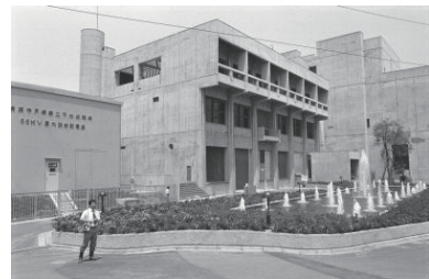
戸塚第二下水処理場竣工(戸塚区) 1974年06月07日 5704
