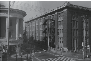
中区散策、生糸検査所(中区) 1975年01月 5989
