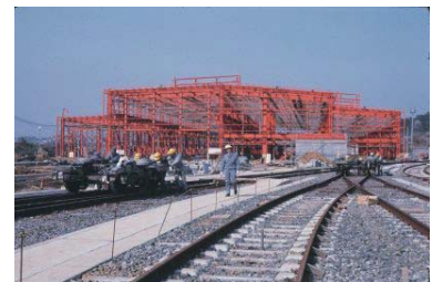
地下鉄上永谷駅工事(港南区) 1976年04月 7349
