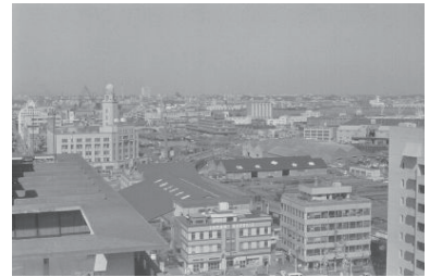
東西上屋倉庫周辺(鳥瞰)(中区) 1976年03月04日 6312
