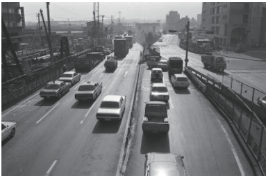
道路工事(西区) 1975年12月02日 6239
