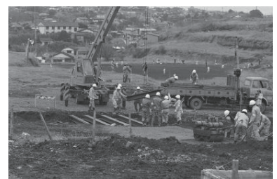
道路確保訓練=清水ヶ丘国大跡地(南区) 1976年03月31日 6327
