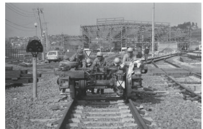
市営地下鉄工事進む=上永谷駅(港南区) 1976年04月05日 6346
