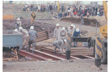
道路確保訓練=清水ヶ丘国大跡地(南区) 1976年03月31日 6456
