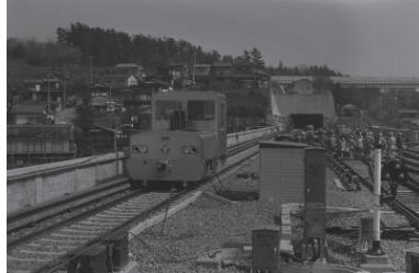
市営地下鉄工事進む=上永谷駅(港南区) 1976年04月05日 6342
