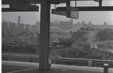
市営地下鉄工事進む=上永谷駅(港南区) 1976年04月05日 6341
