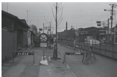
下水道工事=生麦(鶴見区) 1976年04月16日 6369
