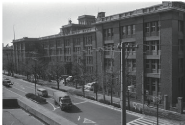
中区散策、生糸検査所(中区) 1975年01月 5990
