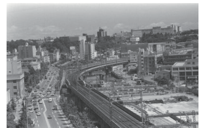
高速道路工事、派大岡川(市庁舎屋上から)(中区) 1976年07月26日 6491
