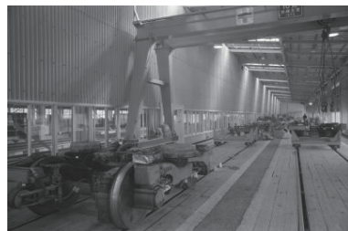
市営地下鉄工事進む=上永谷駅(港南区) 1976年04月05日 6351
