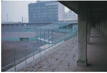
取り壊される平和球場(中区) 1977年01月 7225
