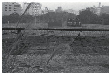
取り壊される平和球場(中区) 1977年02月14日 6727
