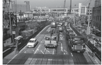
道路工事(西区) 1975年12月02日 6238
