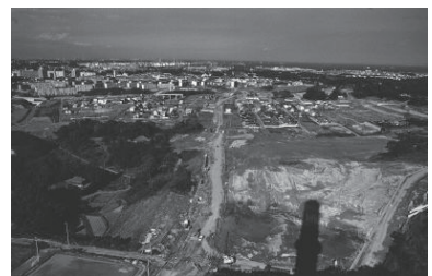
港南工場周辺、宅地造成(港南区) 1974年09月15日 5822
