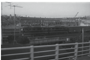
工場解体? 1975年11月07日 6222
