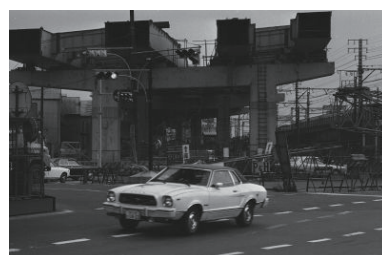
道路工事（西区） 1975年11月 6215
