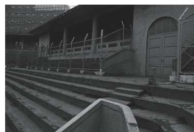
取り壊される平和球場(中区) 1977年02月14日 6724
