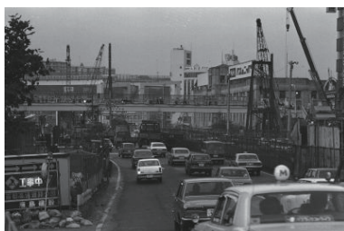
道路工事（西区） 1975年11月 6217
