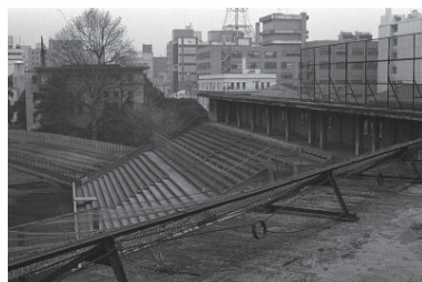
取り壊される平和球場(中区) 1977年02月14日 6726
