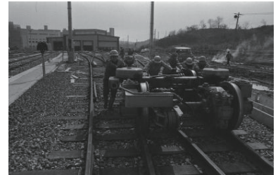
市営地下鉄工事進む=上永谷駅(港南区) 1976年04月05日 6349
