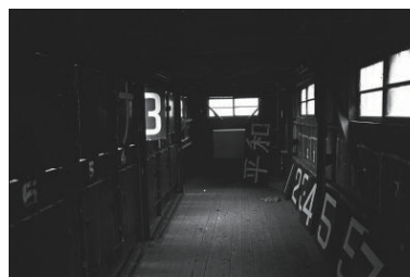
取り壊される平和球場(中区) 1977年02月14日 6730
