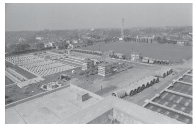
西谷浄水場(保土ヶ谷区) 1976年05月13日 6384
