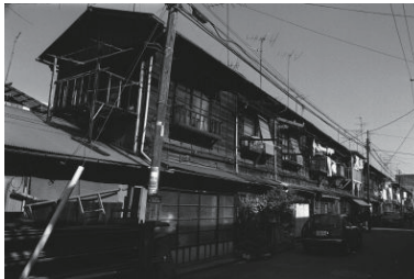
木造共同住宅(中区?) 1976年09月 6597
