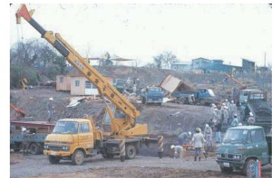
道路確保訓練=清水ヶ丘国大跡地(南区) 1976年03月31日 6455
