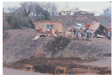
道路確保訓練=清水ヶ丘国大跡地(南区) 1976年03月31日 6453
