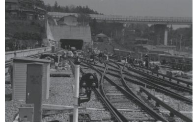
市営地下鉄工事進む=上永谷駅(港南区) 1976年04月05日 6343
