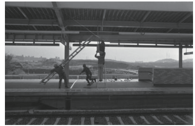
市営地下鉄工事進む=上永谷駅(港南区) 1976年04月05日 6340
