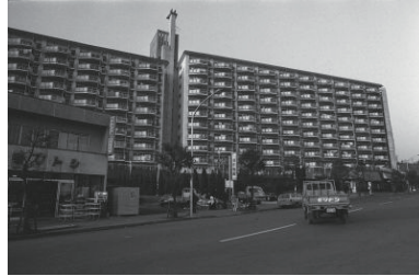
高層住宅(緑区?) 1975年12月02日 6237
