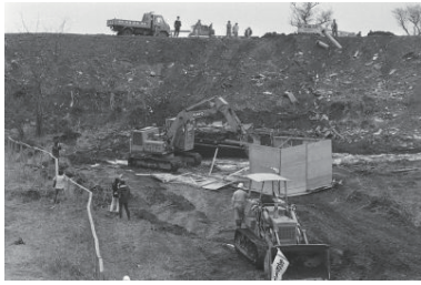
道路確保訓練=清水ヶ丘国大跡地(南区) 1976年03月31日 6328
