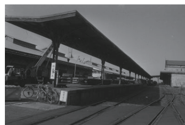
新港埠頭、プラットホーム(中区) 1977年04月 6741
