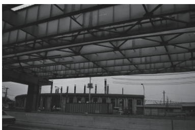
道路工事（西区） 1975年11月 6216
