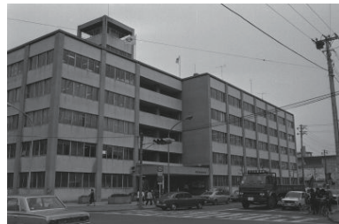
鶴見区総合庁舎外観(鶴見区) 1976年04月16日 6366
