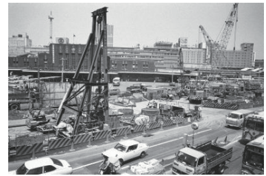
横浜駅東口駅前道路工事(西区) 1974年06月20日 5712
