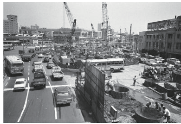
横浜駅東口駅前道路工事(西区) 1974年06月20日 5709
