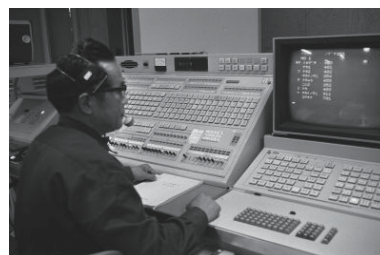
消防局司令室、コンピュータ導入(保土ヶ谷区) 1975年11月14日 6223
