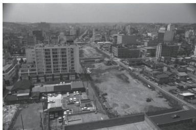
大通り公園整備中(中区) 1975年07月 6036
