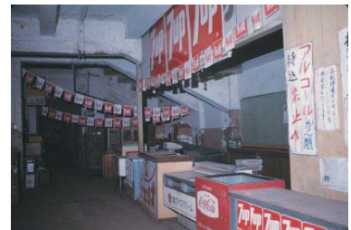
取り壊される平和球場(中区) 1977年01月 7233
