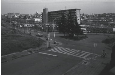
高層住宅(緑区?) 1975年12月02日 6236
