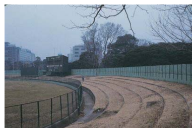
取り壊される平和球場(中区) 1977年01月 7222
