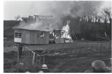
道路確保訓練=清水ヶ丘国大跡地(南区) 1976年03月31日 6330
