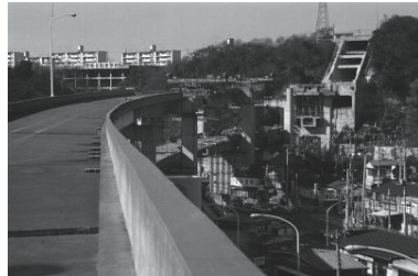
高速道路三ツ沢線、工事中(西区) 1977年01月24日 6692
