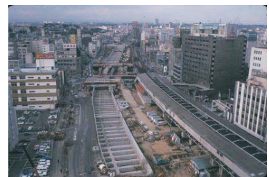
高速道路工事中、関内駅周辺～桜木町方面(中区) 1977年01月 7242
