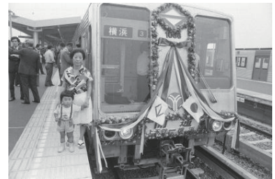
市営地下鉄横浜～上永谷開通(港南区) 1976年09月03日 6580
