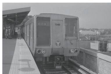
市営地下鉄工事進む=上永谷駅(港南区) 1976年04月05日 6336
