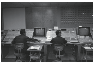
消防局司令室、コンピュータ導入(保土ヶ谷区) 1975年11月14日 6225
