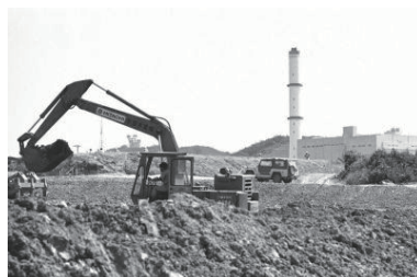
港南工場周辺、宅地造成(港南区) 1974年09月15日 5820
