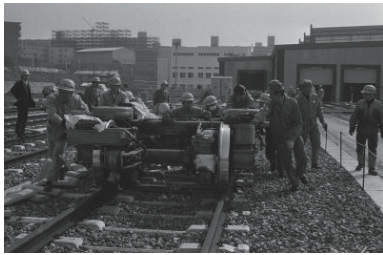
市営地下鉄工事進む=上永谷駅(港南区) 1976年04月05日 6338
