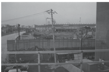
工場解体? 1975年11月07日 6218
