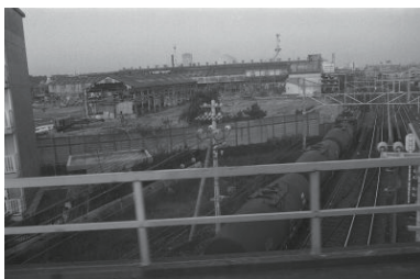
工場解体? 1975年11月07日 6219
