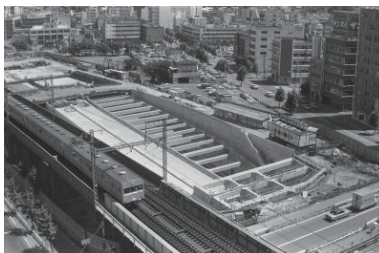
高速道路工事、派大岡川(市庁舎屋上から)(中区) 1976年07月26日 6490
