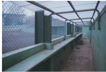
取り壊される平和球場(中区) 1977年01月 7229
