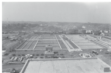
西谷浄水場(保土ヶ谷区) 1976年05月13日 6383
