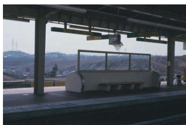
地下鉄上永谷駅工事(港南区) 1976年04月 7350
