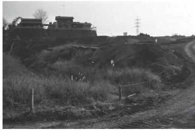
造成(港北区?) 1975年12月02日 6233
