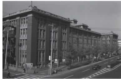
中区散策、生糸検査所(中区) 1975年01月 5988
