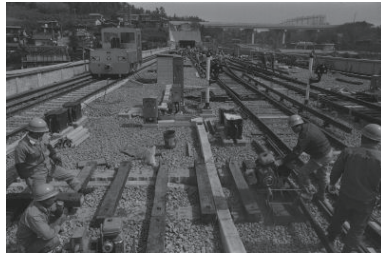
市営地下鉄工事進む=上永谷駅(港南区) 1976年04月05日 6339
