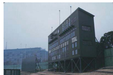
取り壊される平和球場(中区) 1977年01月 7221
