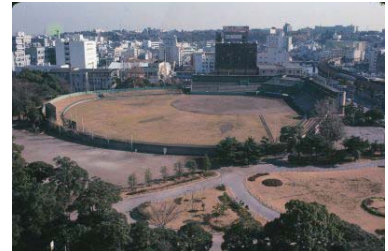
取り壊される平和球場(市庁舎屋上から)(中区) 1977年01月 7236
