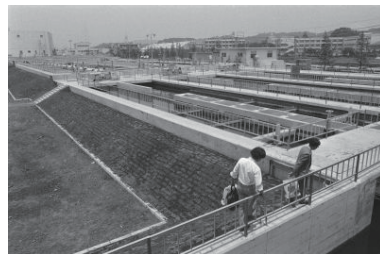
戸塚第二下水処理場竣工(戸塚区) 1974年06月07日 5703
