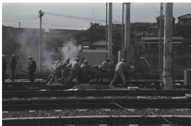
市営地下鉄工事進む=上永谷駅(港南区) 1976年04月05日 6345
