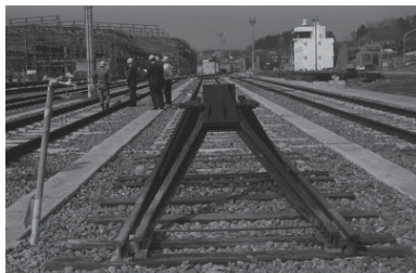
市営地下鉄工事進む=上永谷駅(港南区) 1976年04月05日 6344
