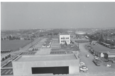
西谷浄水場(保土ヶ谷区) 1976年05月13日 6382
