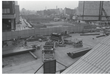
高速道路工事、関内駅付近(吉田川埋立)(中区) 1974年12月10日 5902
