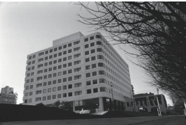
産業貿易センタービル(中区) 1976年01月 6267
