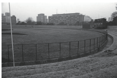
取り壊される平和球場(中区) 1977年02月14日 6728
