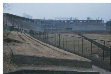
取り壊される平和球場(中区) 1977年01月 7223
