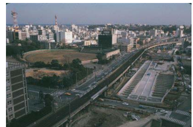
横浜公園、高速道路工事中(教育文化センター屋上から)(中区) 1977年01月 7239
