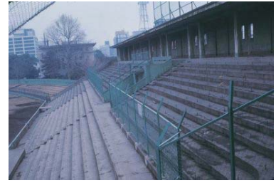
取り壊される平和球場(中区) 1977年01月 7227
