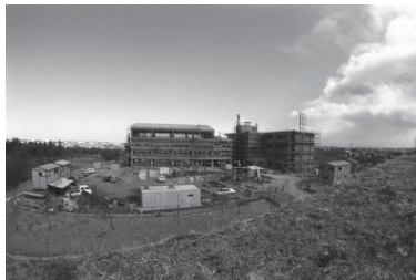
学校建設工事(保土ヶ谷区) 1977年02月05日 6715
