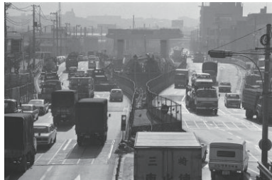
道路工事(西区) 1975年12月02日 6240
