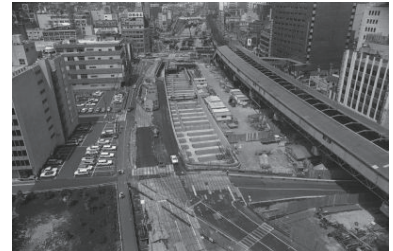
高速道路工事、関内駅西側(中区) 1975年07月 6035
