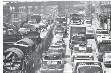
横浜駅東口駅前道路工事、車混雑(西区) 1974年06月 5716
