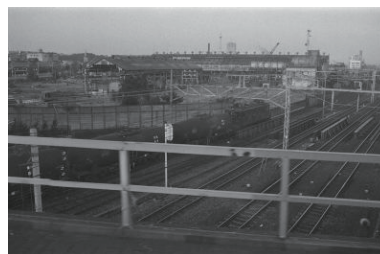
工場解体? 1975年11月07日 6220
