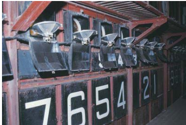
取り壊される平和球場(中区) 1977年01月 7234
