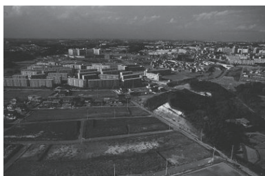
港南工場周辺、宅地造成(港南区) 1974年09月15日 5823
