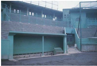
取り壊される平和球場(中区) 1977年01月 7228
