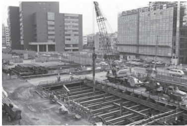
高速道路工事、関内駅付近(中区) 1974年12月10日 5901
