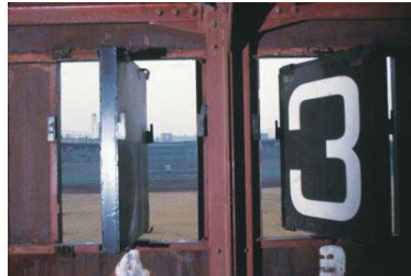
取り壊される平和球場(中区) 1977年01月 7235
