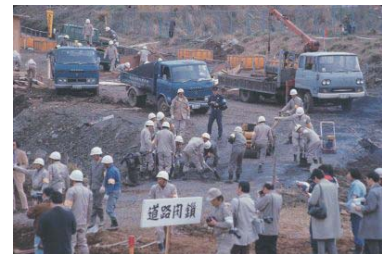
道路確保訓練=清水ヶ丘国大跡地(南区) 1976年03月31日 6454
