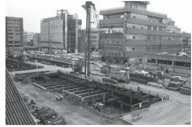
高速道路工事、関内駅付近(中区) 1974年12月10日 5900
