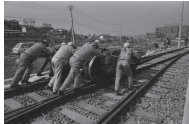
市営地下鉄工事進む=上永谷駅(港南区) 1976年04月05日 6348
