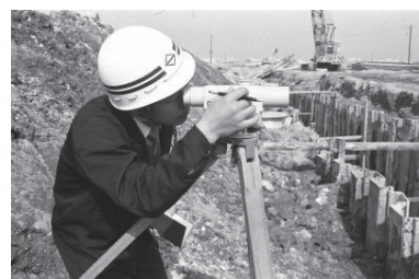
金沢地先下水敷設工事(金沢区) 1974年10月25日 5848
