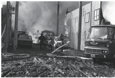
地震対策実験＝金沢地先(金沢区) 1976年10月15日 6608
