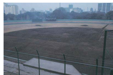
取り壊される平和球場(中区) 1977年01月 7224
