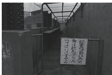
取り壊される平和球場(中区) 1977年02月14日 6722
