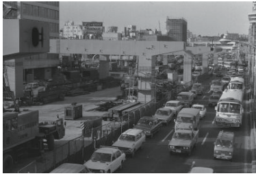
横浜駅東口駅前道路工事、車混雑(西区) 1974年03月01日 5717
