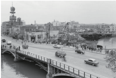
大江橋、根岸線橋脚工事中(中区) 1960年03月21日 1226
