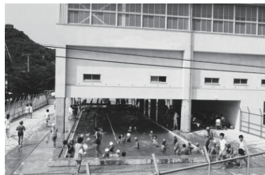
学校プール(磯子区) 1970年09月11日 1785
