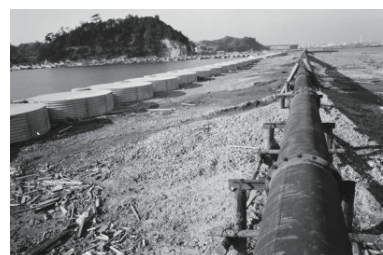
金沢地先埋立(金沢区) 1971年12月 1922
