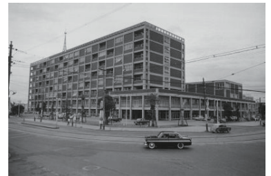
横浜市庁舎全景(中区) 1961年06月 1249
