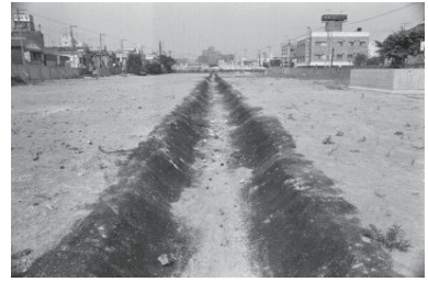
大通り公園建設用地(中区) 1973年07月 5528
