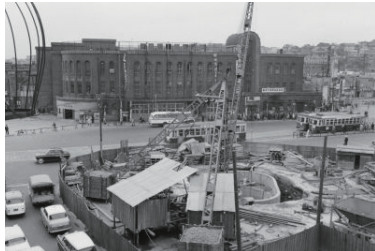
根岸線橋脚工事中、桜木町駅前(中区) 1960年03月21日 1227
