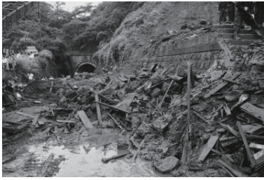
集中豪雨による崖崩れ（中区北方町）(中区) 1961年06月29日 1252
