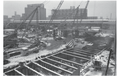
地下鉄工事(中区) 1972年02月07日 5021
