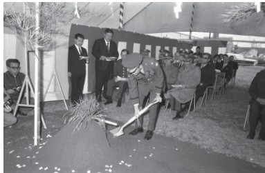
モータープール移転による地鎮祭(神奈川区) 1973年04月05日 5424
