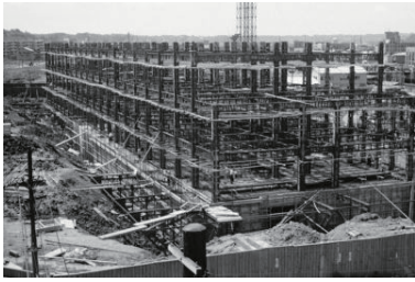
横浜市庁舎建設中(中区) 1958年 1081
