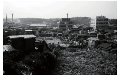
保土ヶ谷区新庁舎周辺(保土ヶ谷区) 1969年11月25日 1632
