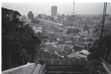
高速道路三ツ沢線工事中(西区) 1973年10月 5585
