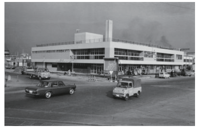
完成間近の港湾厚生センター(山下埠頭)(中区) 1964年12月 1375
