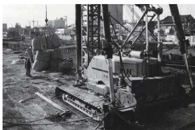
地下鉄工事河川埋立 1971年01月23日 1816
