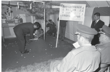
モータープール移転による地鎮祭(神奈川区) 1973年04月05日 5423
