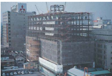
関内駅前中央ビル建設中(中区) 1972年02月 5633
