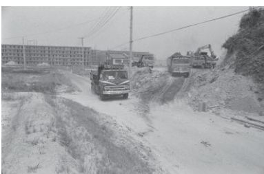
宅地造成、住宅建設建設(港南台)(港南区) 1973年07月 5514
