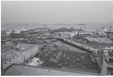
県庁屋上からの眺望（新港埠頭）(中区) 1970年03月13日 1678
