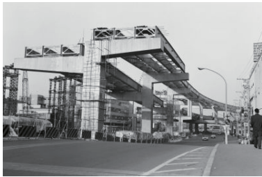
横羽線Ⅱ期工事進む(西区) 1971年12月 1927
