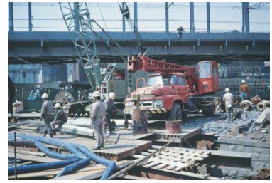
地下鉄工事(中区) 1972年02月 5016
