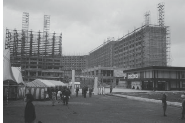
根岸線磯子～洋光台駅開通式、洋光台駅前広場(磯子区) 1970年03月17日 1685
