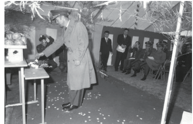
モータープール移転による地鎮祭(神奈川区) 1973年04月05日 5425
