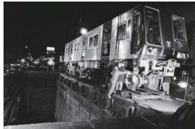
地下鉄車両搬入 1971年03月18日 1829
