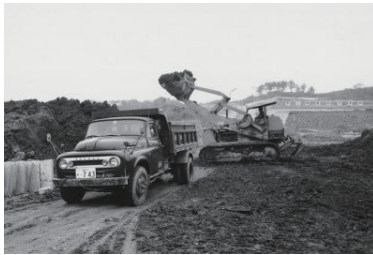
宅地造成 1965年10月 1405
