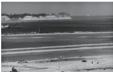
根岸湾の埋立、崖の上に八聖殿 1962年03月 1284
