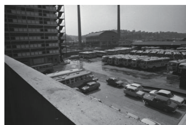
市営川辺町住宅(保土ヶ谷区) 1972年04月21日 5176
