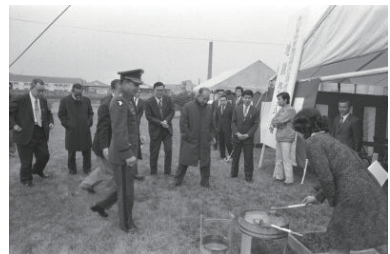
モータープール移転による地鎮祭(神奈川区) 1973年04月05日 5422
