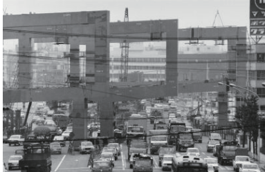
横羽線Ⅱ期工事すすむ(西区) 1971年06月30日 1863
