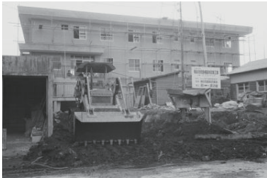
児童相談所改築工事(保土ヶ谷区) 1966年11月 1469
