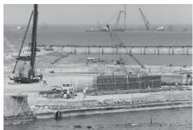
金沢地先埋立(金沢区) 1971年08月13日 1884
