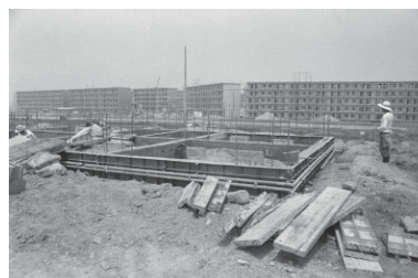
宅地造成、住宅建設建設(港南台)(港南区) 1973年07月 5513
