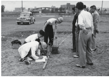
新市庁舎建設予定地(港町)地質調査(中区) 1956年 1169
