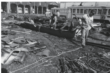
市電解体(滝頭車庫)(磯子区) 1971年11月 1913
