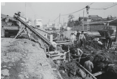
道路工事(上大岡～日野) (港南区) 1967年02月18日 1478
