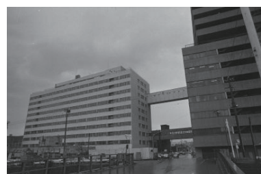
市大病院第2新館(南区) 1972年04月15日 5188
