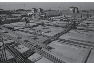
西谷浄水場、水道8拡工事(西区) 1973年01月30日 5400
