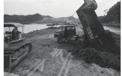
金沢地先埋立(金沢区) 1971年08月13日 1883
