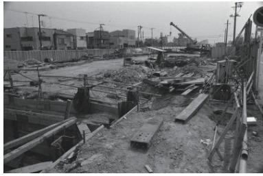
大通り公園建設用地(中区) 1973年07月 5526
