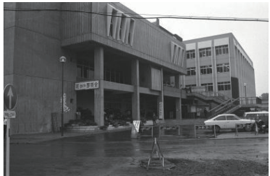
緑区役所新庁舎(緑区) 1972年05月13日 5209
