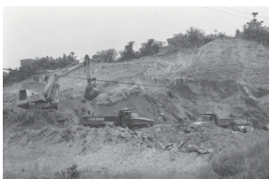
宅地造成、住宅建設建設(港南台)(港南区) 1973年07月 5515
