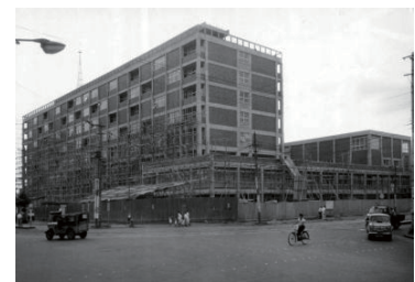
完成間近の横浜市庁舎(中区) 1959年 1207
