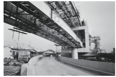
横羽、三ツ沢線工事進む(西区) 1971年12月 1926
