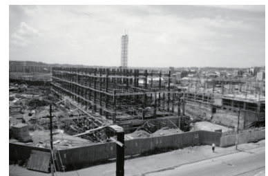
横浜市庁舎建設中(中区) 1958年 1080
