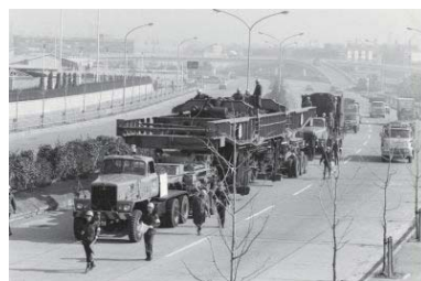
機関車(D51)、市民公園へ搬送(中区) 1971年02月09日 1818
