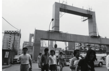
横羽線Ⅱ期工事すすむ(西区) 1971年06月30日 1864
