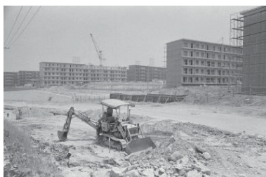
宅地造成、住宅建設建設(港南台)(港南区) 1973年07月 5512
