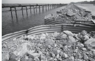
金沢地先埋立(金沢区) 1971年08月13日 1882
