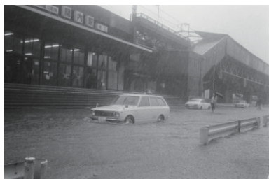
豪雨による水害(中区)
