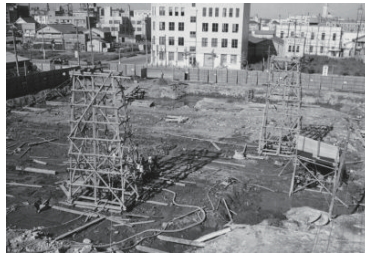
新市庁舎工事始まる(中区) 1956年 1170
