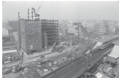
関内駅工事中(中区) 1973年06月 5394
