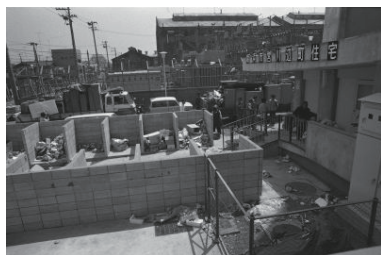
市営川辺町住宅入居始まる(保土ヶ谷区) 1972年04月14日 5173
