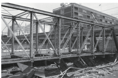
取り壊される港橋(中区) 1973年06月25日 5391
