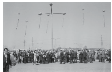
新横浜駅西口区画整理事業起工式(港北区) 1966年03月17日 1444
