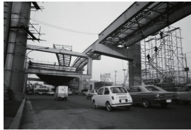
横羽線Ⅱ期工事進む(西区) 1971年12月 1928
