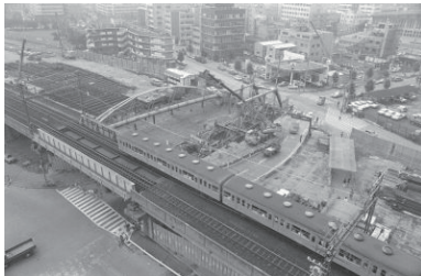
取り壊される港橋(中区) 1973年06月 5393
