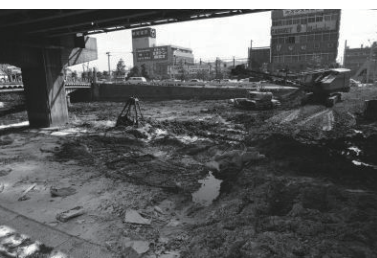
派大岡川埋立、高速道路建設(中区) 1972年05月11日 5195
