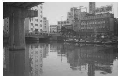
根岸線橋下、派大岡川・吉田橋(中区) 1966年01月21日 1419
