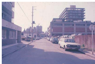
山下公園周辺(中区) 1973年05月 5653
