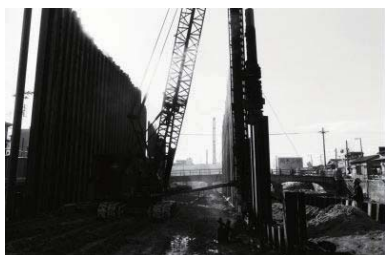
地下鉄工事河川埋立 1971年01月23日 1814
