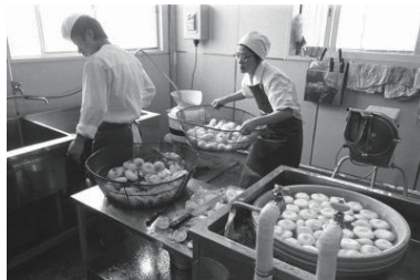
給食調理室=南太田小学校(南区) 1972年04月 5142
