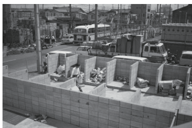
市営川辺町住宅入居始まる(保土ヶ谷区) 1972年04月14日 5174
