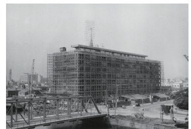
新市庁舎の建設進む(中区) 1959年 1206
