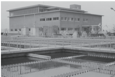
南部下水処理場(磯子区) 1966年07月22日 1459
