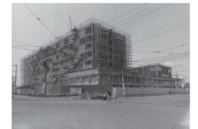
新市庁舎の建設進む(中区) 1959年 1205
