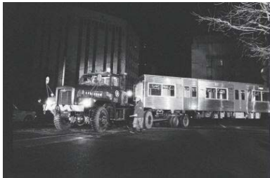
地下鉄車両搬入 1971年03月18日 1828
