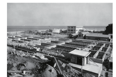
中部下水処理場(中区) 1962年05月 1273
