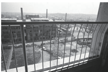
市営川辺町住宅(保土ヶ谷区) 1972年04月21日 5179
