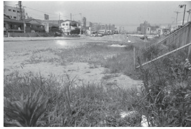
大通り公園建設用地(中区) 1973年07月 5527
