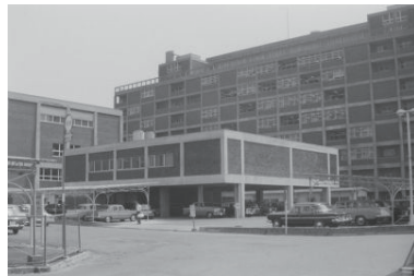
横浜市機械事務センター(中区) 1966年08月 1462
