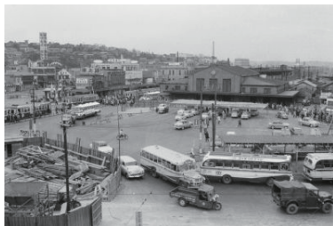
桜木町駅前、根岸線橋脚工事中(中区) 1960年03月21日 1224
