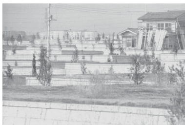
新興住宅、宅地造成(旭区) 1972年02月09日 5045
