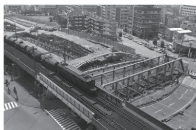
取り壊される港橋(中区) 1973年06月25日 5392
