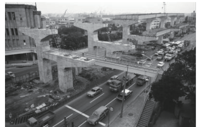
横羽線工事(神奈川公園付近)(西区) 1970年10月15日 1793
