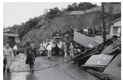
集中豪雨による崖崩れ(中区北方町)(中区) 1961年06月29日 1251
