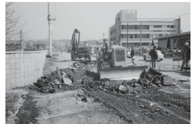
道路工事(上大岡～日野) (港南区) 1967年02月18日 1477
