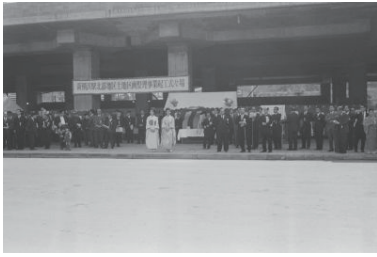
新横浜駅西口区画整理事業起工式(港北区) 1966年03月17日 1445
