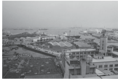
県庁屋上からの眺望（新港埠頭、横浜税関、大棧橋）(中区) 1970年03月13日 1679
