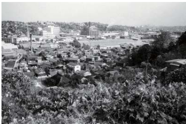
保土ヶ谷区新庁舎周辺(保土ヶ谷区) 1969年11月25日 1633
