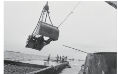
金沢地先埋立(金沢区) 1971年09月09日 1889
