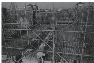
西谷浄水場、水道8拡工事(西区) 1973年01月30日 5401
