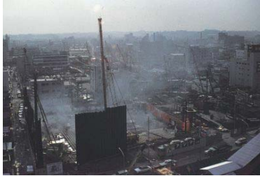
地下鉄工事、教育文化センター建設中(中区) 1972年02月 5018
