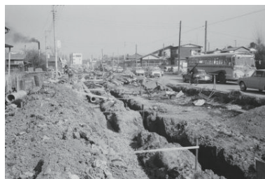
道路工事(上大岡～日野) (港南区) 1967年02月18日 1479
