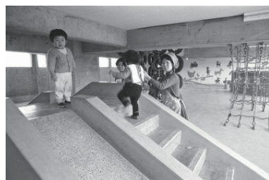
市営川辺町住宅(保土ヶ谷区) 1972年04月21日 5180
