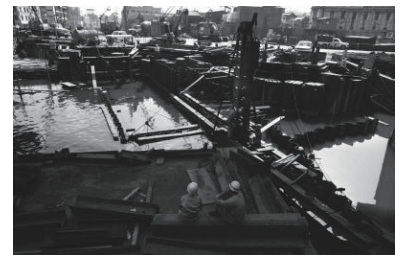
派大岡川埋立、高速道路建設(中区) 1972年05月11日 5194
