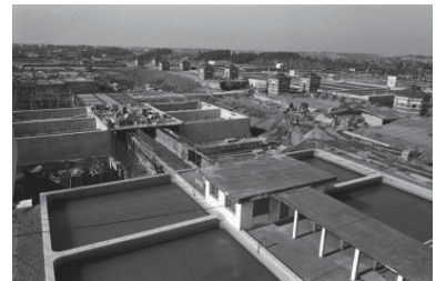
西谷浄水場、水道8拡工事(西区) 1973年01月30日 5399
