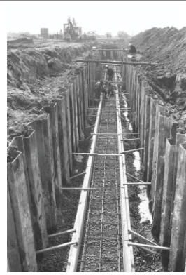
金沢地先下水敷設工事(金沢区) 1974年10月25日 5849
