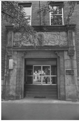
関東財務局（玄関上部イ ラム風装飾）(中区) 1977年10月 7067
