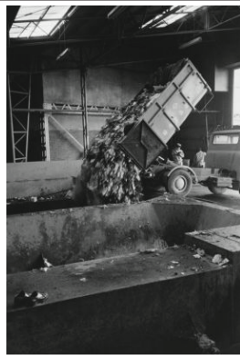
星川ごみ処理場(保土ヶ谷区)
