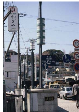
長者橋親柱(中区)
