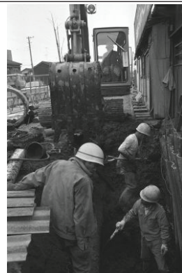
下水道工事=生麦(鶴見区) 1976年04月16日 6368
