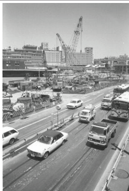
横浜駅東口駅前道路工事(西区)
