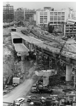
高速道路工事(中区)
