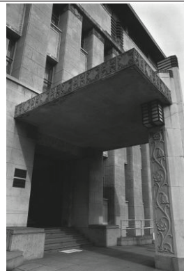
横浜銀行協会（玄関車寄せ）(中区)
