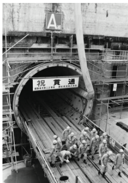
市営地下鉄3号線、横浜一 新横浜間の導坑貫通(港北区)
