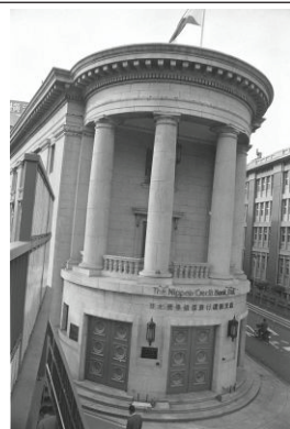
建築物の外観装飾とデザイン、日本債券信用銀行横浜支店(中区)
