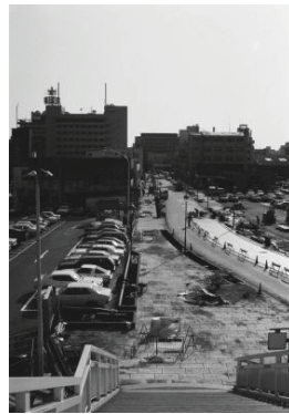
大栈橋入り口道路の歩道拡 張工事(中区)
