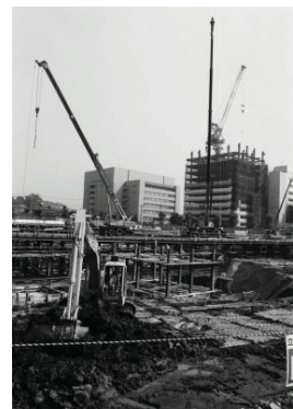
建設進むアリーナ(港北区)
