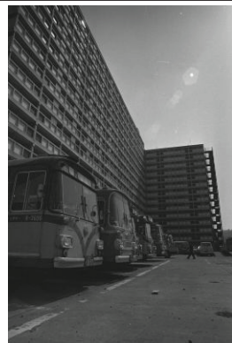
市営川辺町住宅(保土ヶ谷区)
