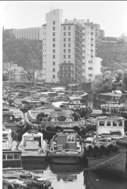
西の橋付近中村川、ハシケなど(中区)
