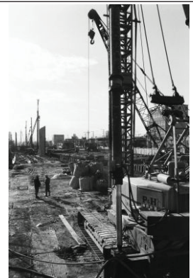
地下鉄工事河川埋立
