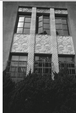
協同電気（壁面）（中区）
