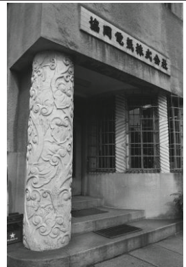
協同電気（玄関）（中区）
