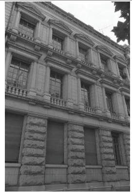
日本火災海上（壁面）（中区）
