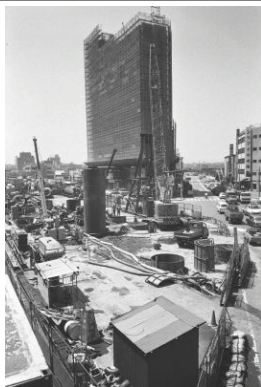
横浜駅東口駅前道路工事(西区)
