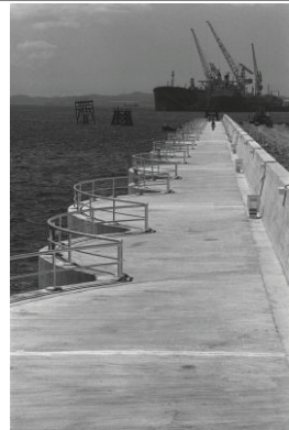
本牧海づり施設竣工(中区)
