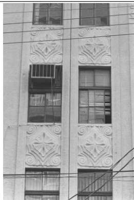
倉田ビル（壁面）(中区)
