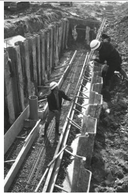
金沢地先下水敷設工事(金沢区) 1974年10月25日 5847
