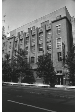
建築物の外観装飾とデザイン、川崎汽船(中区)
