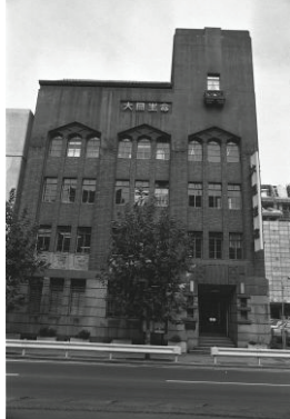
建築物の外観装飾とデザイン、大同生命(中区)
