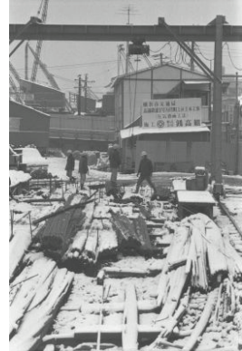
地下鉄工事(中区)
