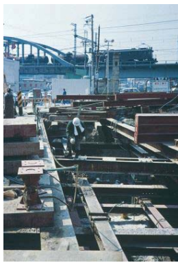
地下鉄工事(中区)
