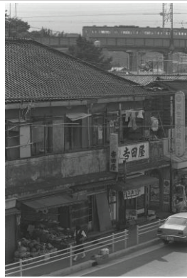
根岸線新杉田駅付近(磯子区)
