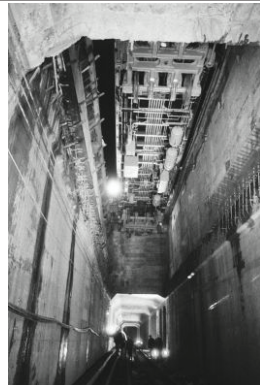
地下鉄車両搬入 1971年03月18日 1830
