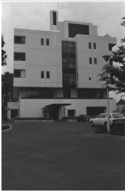
公舎研究所外観(磯子区) 1976年06月16日 6529
