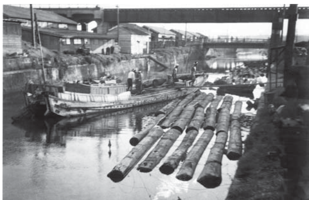
写真⑪ 石崎川 高架は京浜急行線 年不詳 須田宏家資料
