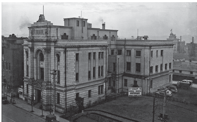
写真⑨ 接収された横浜取引所ビル 1949年1月6日 米国立公文書館所蔵
