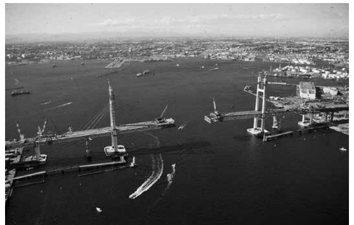
建設中の横浜ベイブリッジ 1989年か 広報課写真資料
