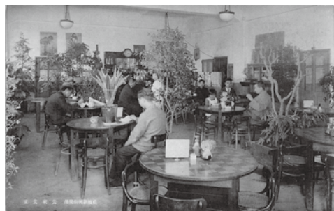
図6 「横浜新興倶楽部 公衆食堂」 昭和7（1932）年
