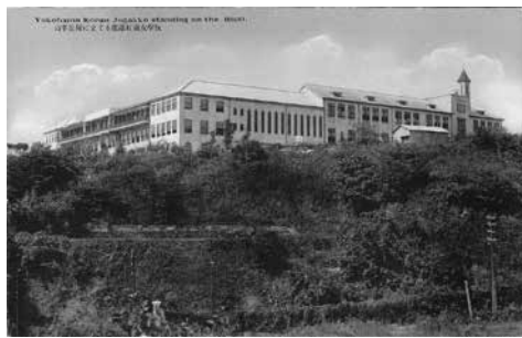
図3「山手丘陵に立てる横浜紅蘭女学校」大正14（1925）年 総工費38万円余、鉄筋3階建ての震災復興建築は「モダン・フレンチ式」と評された。同校は戦後横浜雙葉中学校・高等学校となった。
