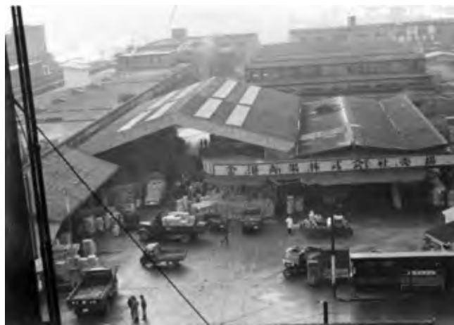
諸車置場等を改築した卸売場 1958(昭和33)年頃 (市史資料室所蔵)
