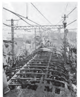
写真5「電車の状態」(No.7) 焼けて骨組みだけになった車両上部
