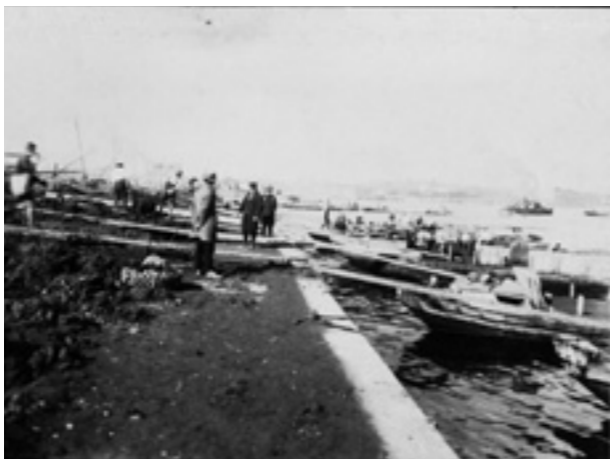
埋立地の整地作業 大正末期 『横浜市復興復旧浚渫工事記念写真帳』
