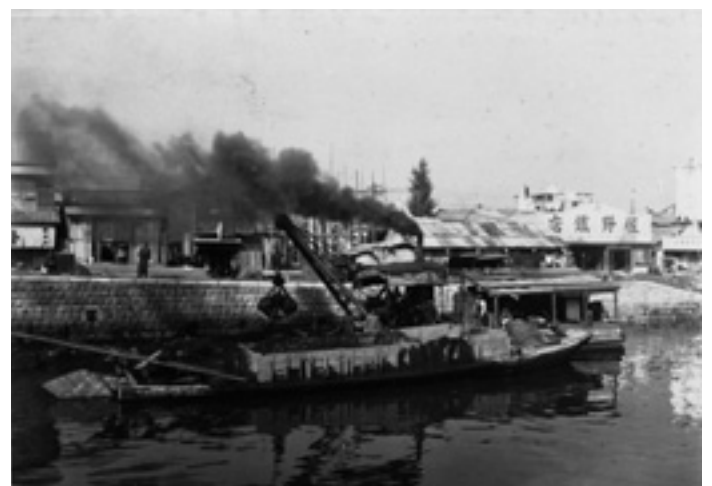
大岡川の土砂を積む浚渫船 大正末期 『横浜市復興復旧浚渫工事記念写真帳』
