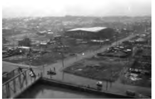
屋根が崩落した横浜文化体育館(中央の白い部分が落下した屋根) 広報課写真資料
