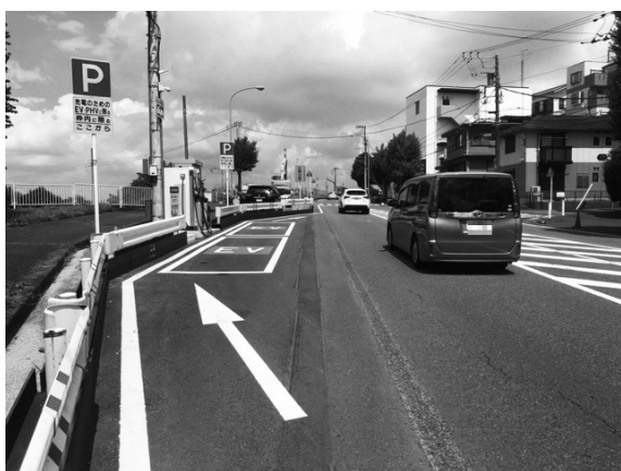
EV充電器の公道設置に関する実証実験（青葉区しらとり台）
