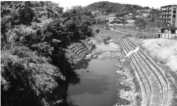
いたち川尾月橋下流完成
