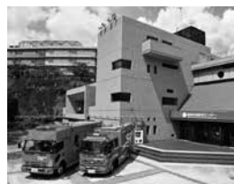
市民防災センター外観
