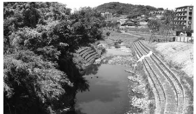
いたち川尾月橋下流完成
