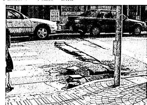
交差点での車道部の損傷
