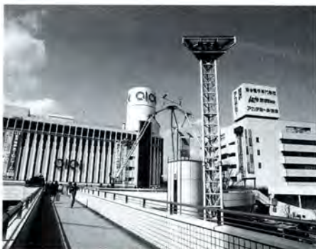
再開発による活性化が期待されている戸塚西口商店街。文化的色彩も加わった、特徴のある商店街づくりが模索されている。
