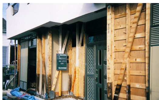
＜木造家屋耐震補強工事の事例＞
