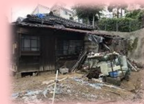
整備前（空き家）
