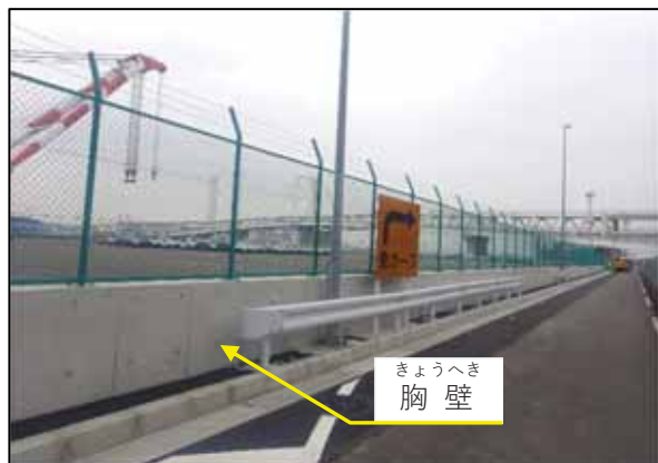
大黒ふ頭に整備した胸壁
