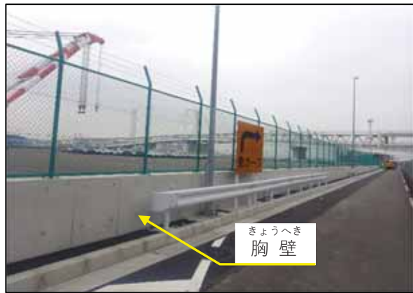
大黒ふ頭に整備した胸壁
