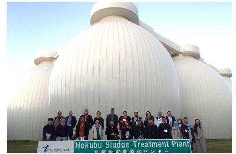
Bコース：北部汚泥資源化センター
